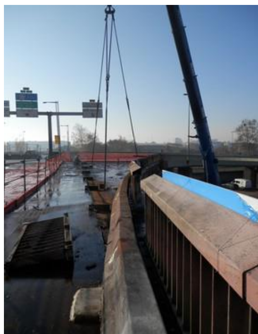
Figure 15 : Dépose de l'élargissement - Source : Cerema
