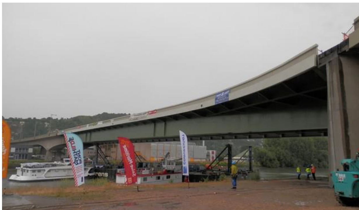
Figure 21 : repose de la travée métallique - Source : Cerema
