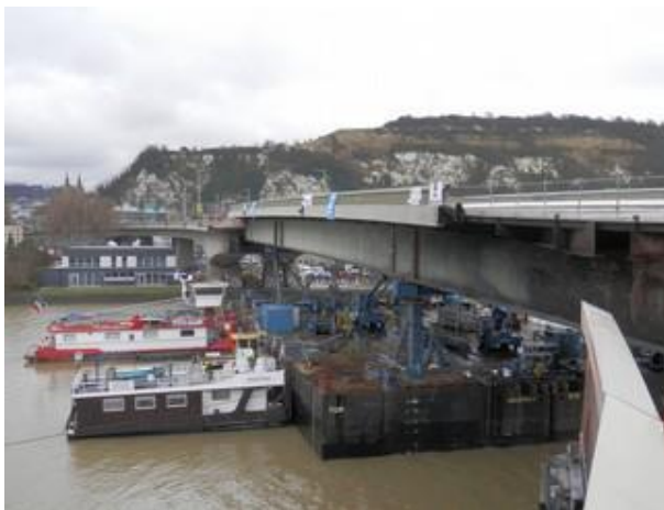
Figure 16 : Prise en charge de la travée par la barge- Source : Cerema
