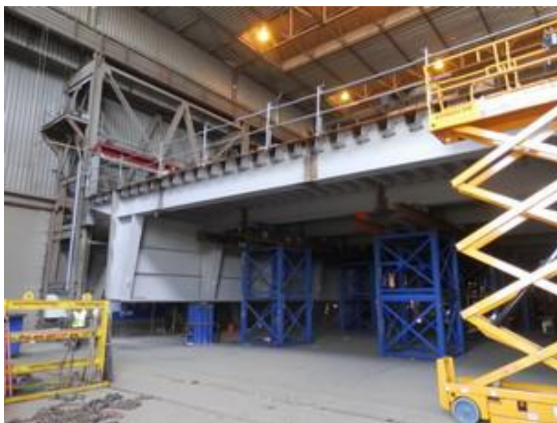
Figure 18 : Fabrication du tronçon neuf - Source : Cerema
