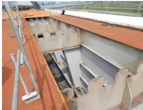
Figure 20 : Remplacement partiel du platelage - Source : Cerema
