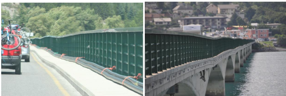
Figure 3 Vue actuelle du pont d'un point de vue usager (© J-M. Torrenti)
