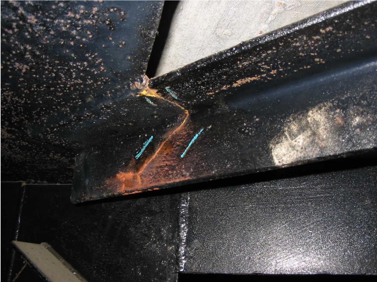
Illustration 2 : Exemple de fissure observée sur l'ouvrage
