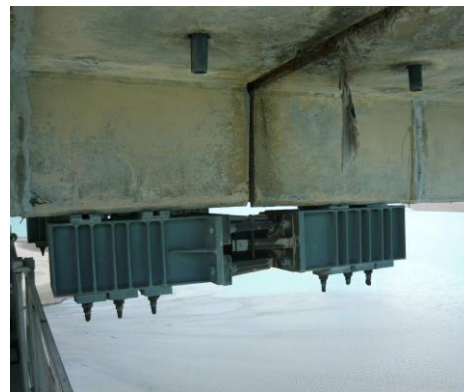
Figure 2 Vue détaillée d'une des articulations (© DIR Méditerranée)
