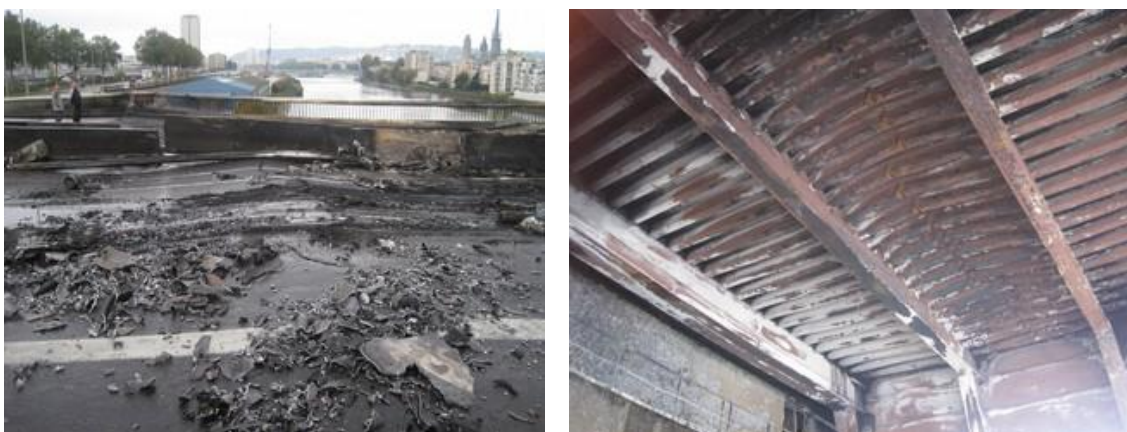
Figure 4 : Déformation de la dalle orthotrope - Source : Cerema
