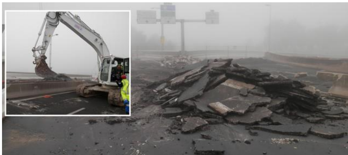
Figure 14 : Démolition du complexe étanchéité-roulement - Source : Cerema
