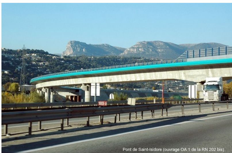
Figure 7 : Vue générale du pont sur le Var à St-Isidore (source : DDE 06)
