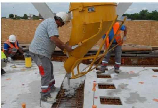
Figure 14 : bétonnage des zones de clavage
