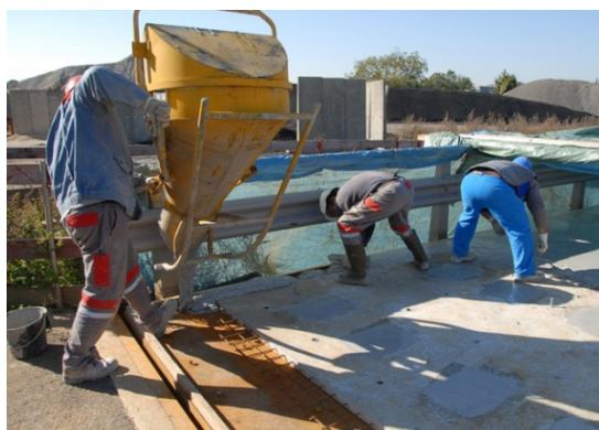
Figure 6 : tablier VMD - Bétonnage des clavages
