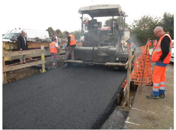
Figure 2 : pose du revêtement Orthochape® sur le corps d'épreuve
