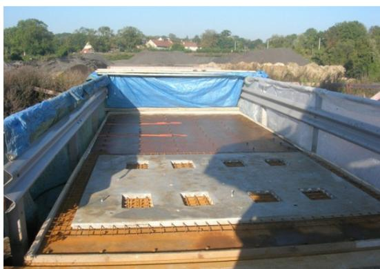
Figure 6 : tablier VMD - Dalle préfabriquée
