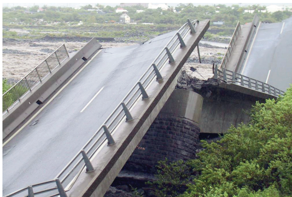
Photos 5 et 6 : Affouillements des appuis
