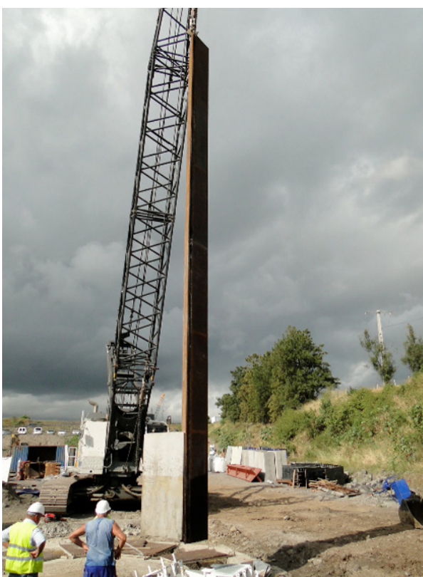
Photos 12 et 13 : Coffrage intérieur d'une barrette primaire
