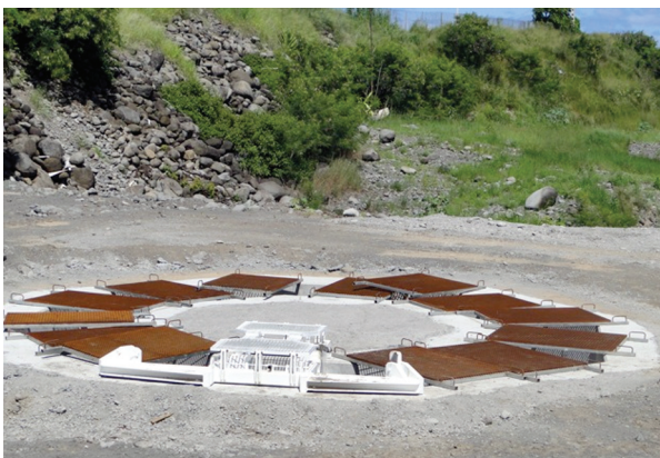
Photo 10 : Murettes guides en béton et photo 11 guide métallique du coffrage intérieur des barrettes primaires
