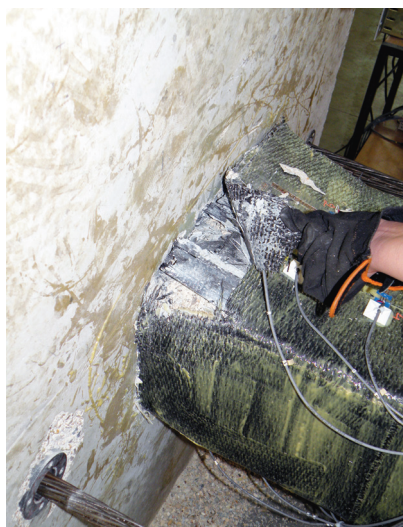
Figure 7 : Ruine prématurée du procédé d'ancrage
