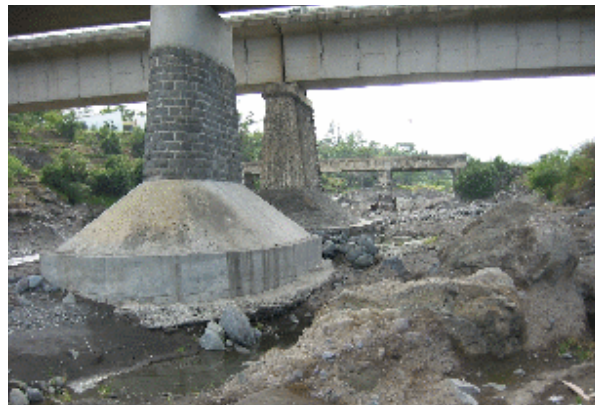
Photos 5 et 6 : Affouillements des appuis
