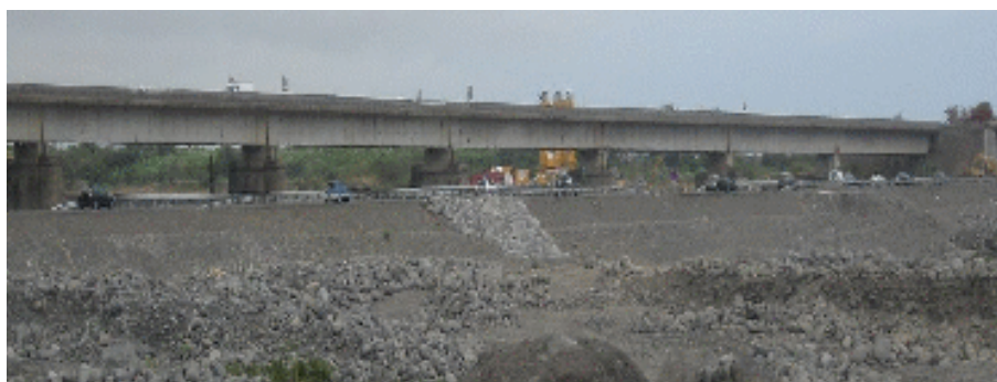
Photo 7 : Radier en cours de construction
