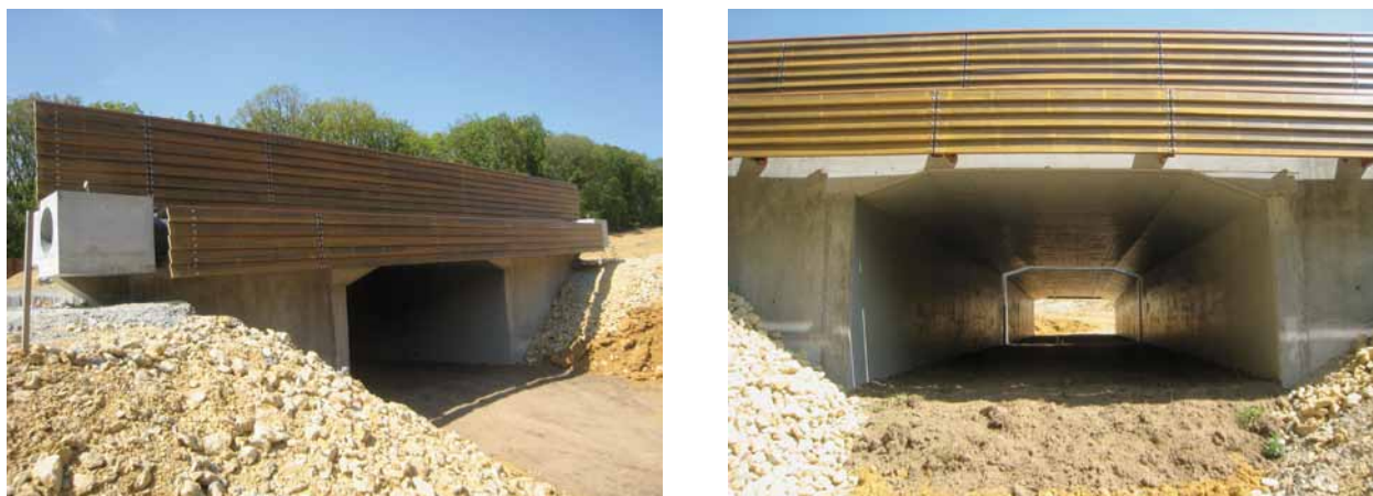
Figure 3 : Vues du PICF de Challuy – Source : CETE de Lyon.
