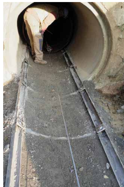
Photo 17 : tractage du 1 er élément de chemisage Source : André Moutengou (DIRA)
