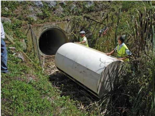
Photo 5 : présentation du gabarit à l'entrée amont de la buse Source : Pascal Poyer entreprise ETC
