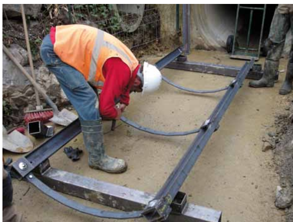
Photo 8 : Assemblage du berceau de pose Source : Pascal Poyer entreprise ETC
