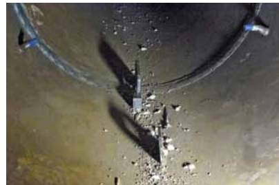
Photo 20 : étanchéité des joints entre éléments Source : André Moutengou (DIRA)
