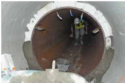
Photo 18 : joint de compartimentage en cours de réalisation Source : André Moutengou (DIRA)
