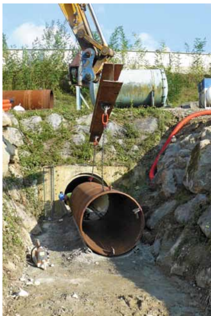
Photo 14 : déchargement et pose d'un élément sur le berceau Source : André Moutengou (DIRA)
