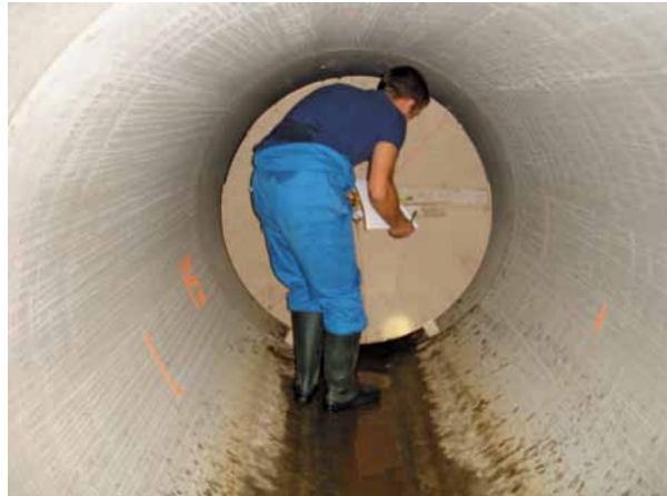
Photo 6 : mesure de l'espace annulaire entre gabarit et buse BA à chaque joint de buse Source : Pascal Poyer entreprise ETC
