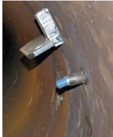
Photo 11 : réglage de deux éléments par interposition d'une cale métallique provisoire Source : André Moutengou (DIRA)
