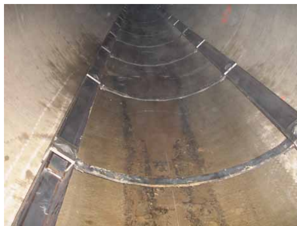
Photo 9 : berceau de pose réglé avant fixation et blocage par béton Source : Pascal Poyer entreprise ETC
