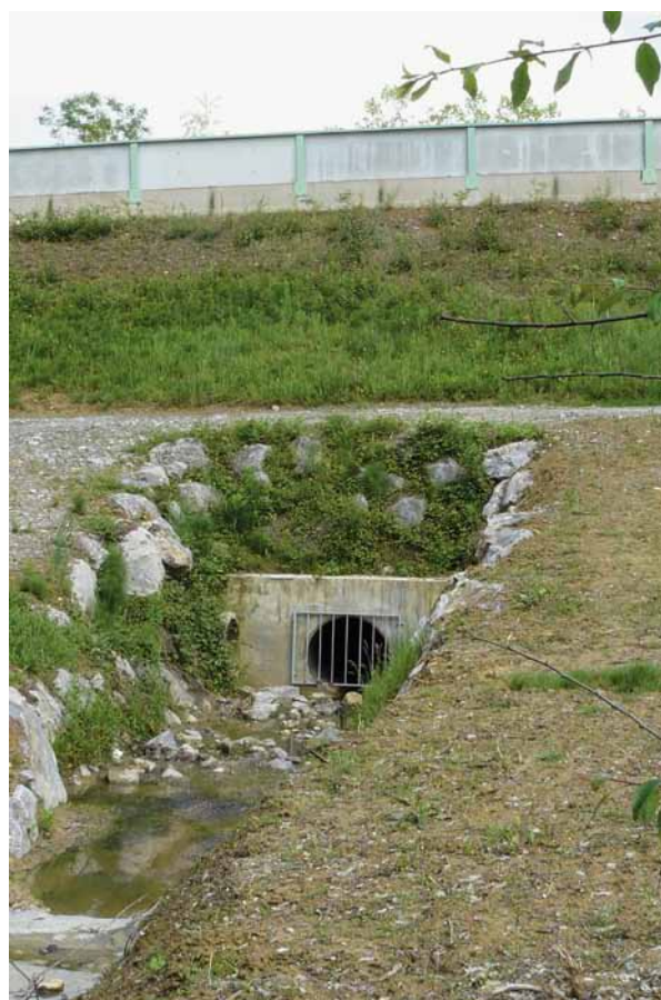
Photo 1 : vue générale ouvrage hydraulique-remblai Source : André Moutengou (DIRA)
