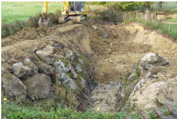
Photo 12 : plate-forme amont en cours de terrassement Source : André Moutengou (DIRA)
