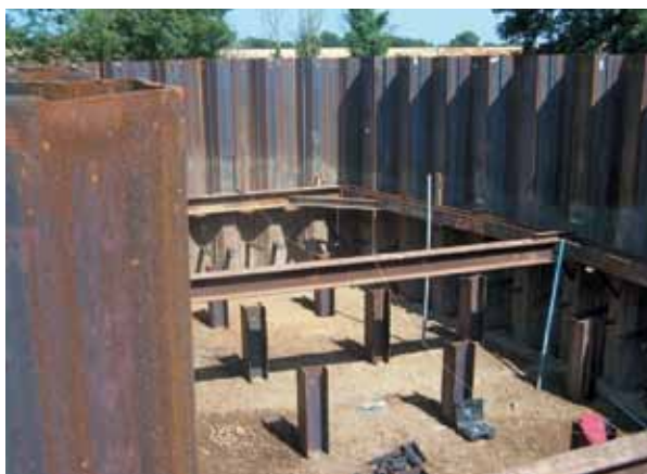
Figure 8.1 : palplanches PU18 Source : DOA du CETE du Sud Ouest
