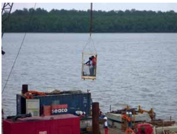
Figure 8 : moyen d'accès au chevêtre Source : DDE 973
