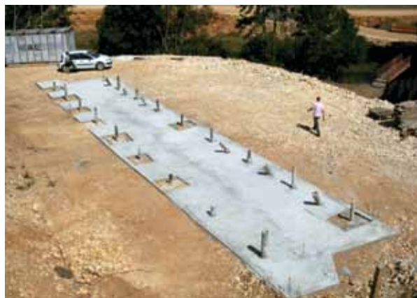
Figure 7.2 : vue de dessus en phase de chantier Source : DOA du CETE du Sud Ouest
