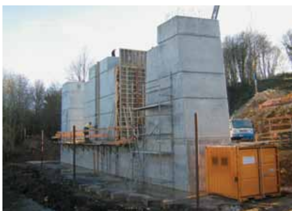
Figure 9 : construction de la pile Source : DOA du CETE du Sud Ouest
