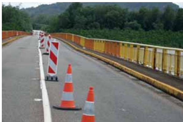
Figure 5 : tablier du Larivot instrumenté Source : LRPC Bordeaux
