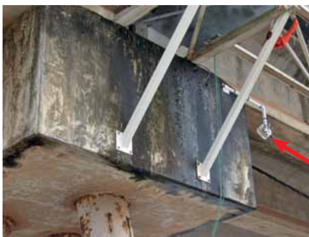
Figure 13 : antenne wi-max (internet) – Source : LRPC Bordeaux
