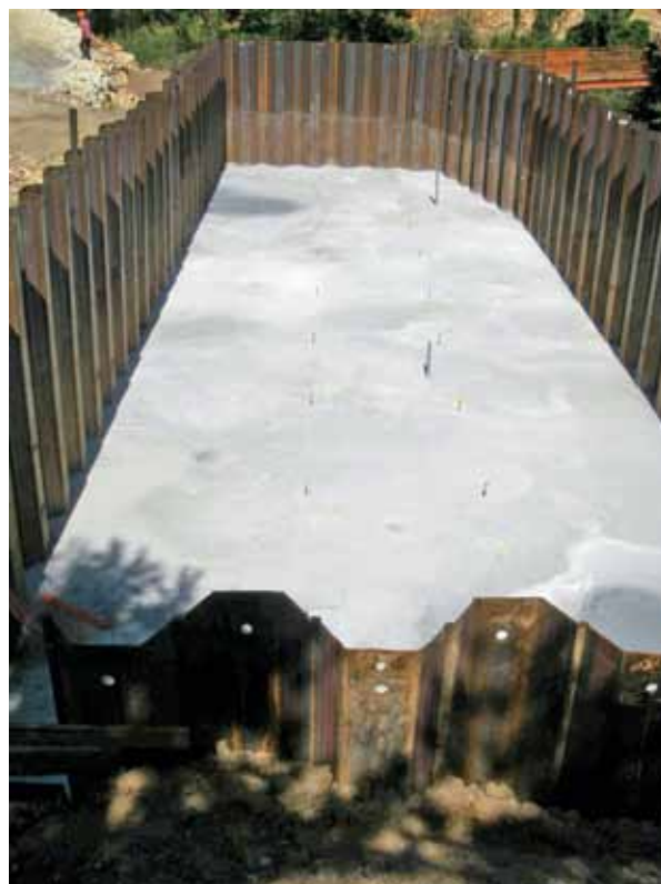
Figure 8.3 : fin du coulage du gros béton Source : DOA du CETE du Sud Ouest
