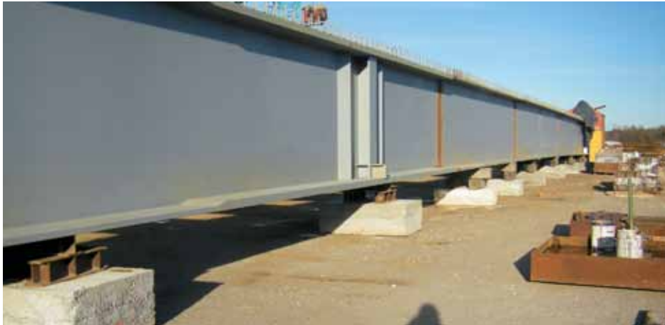
Figure 6 : assemblage de la charpente – Source : DOA du CETE du Sud Ouest
