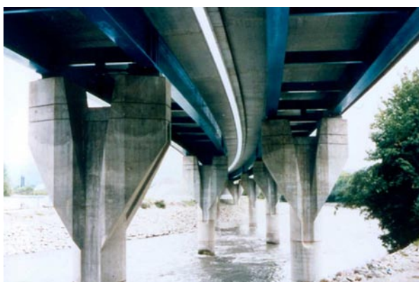
Piles et sous face du tablier
