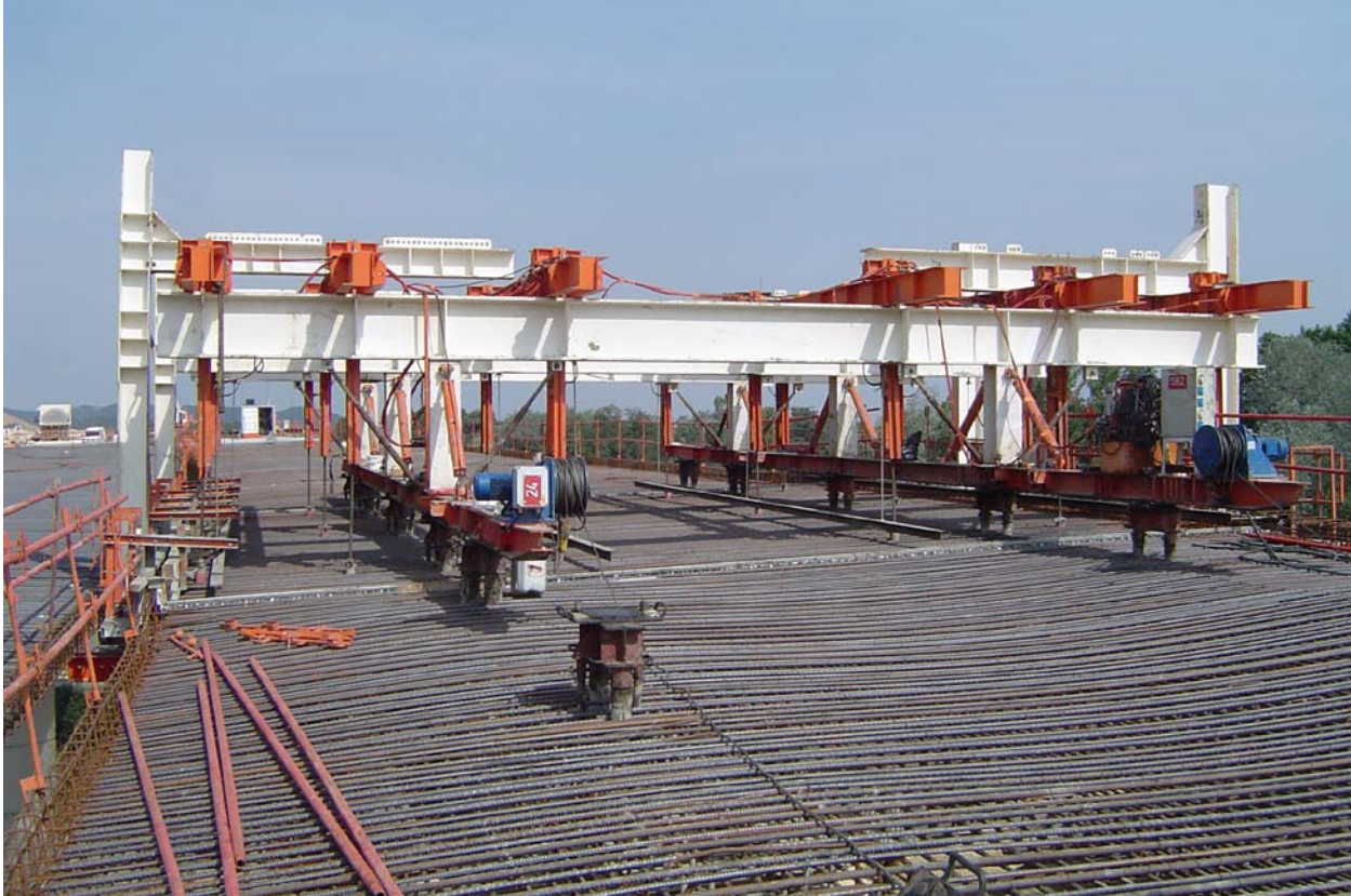
Construction de la dalle avec des équipages mobiles
