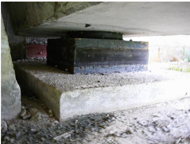
Figure 3 : Exemple d'appareil d'appui en élastomère
