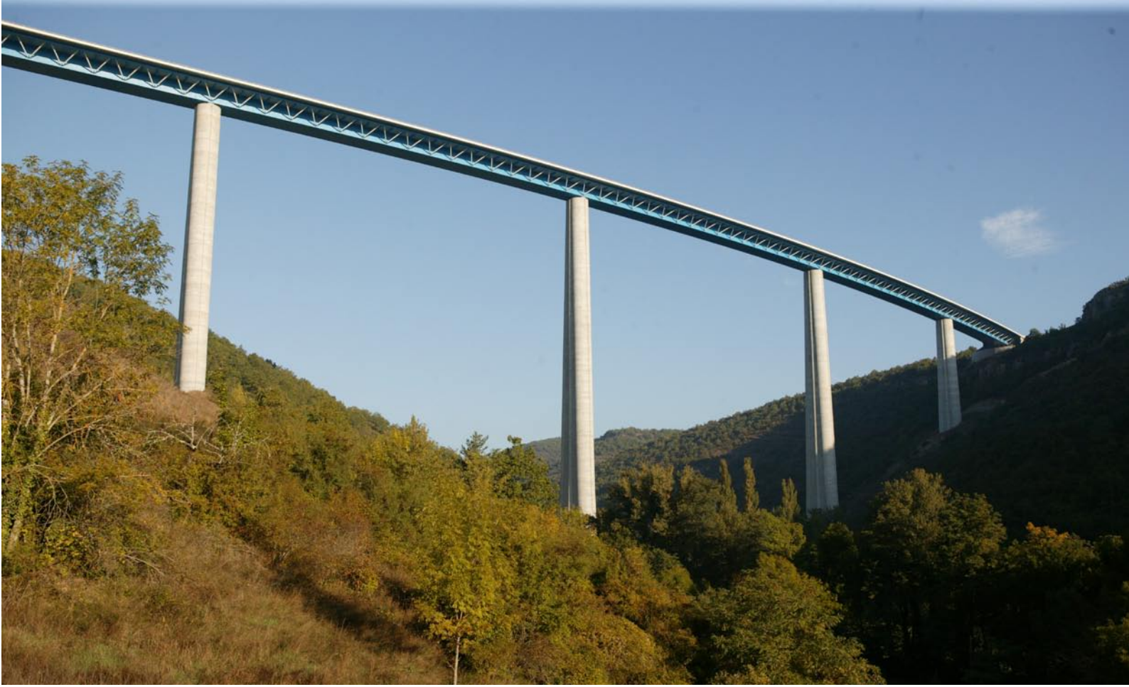
Le viaduc de Verrières
