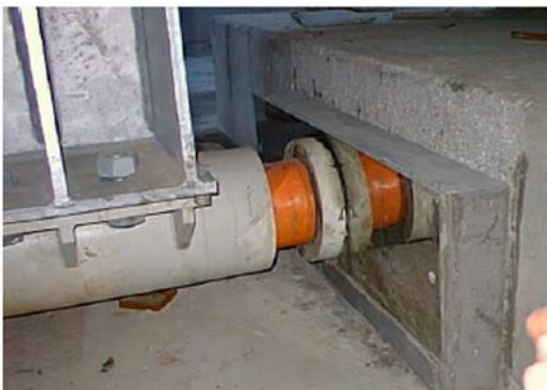
Figure 16 : Exemples de dispositifs amortisseurs à ressort précontraint
