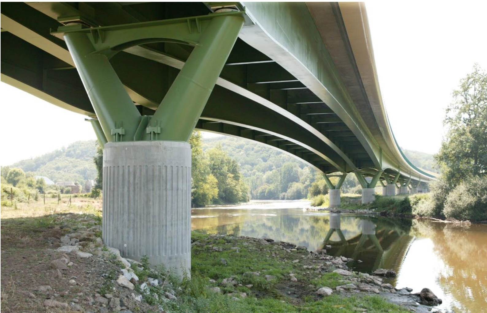
Le viaduc sur la Vézère pour A89
