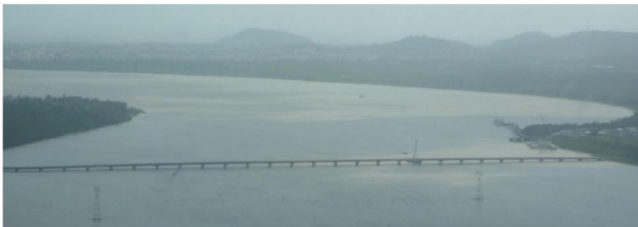
Figure 1 : Vue aérienne du pont du Larivot – source : Sétra
