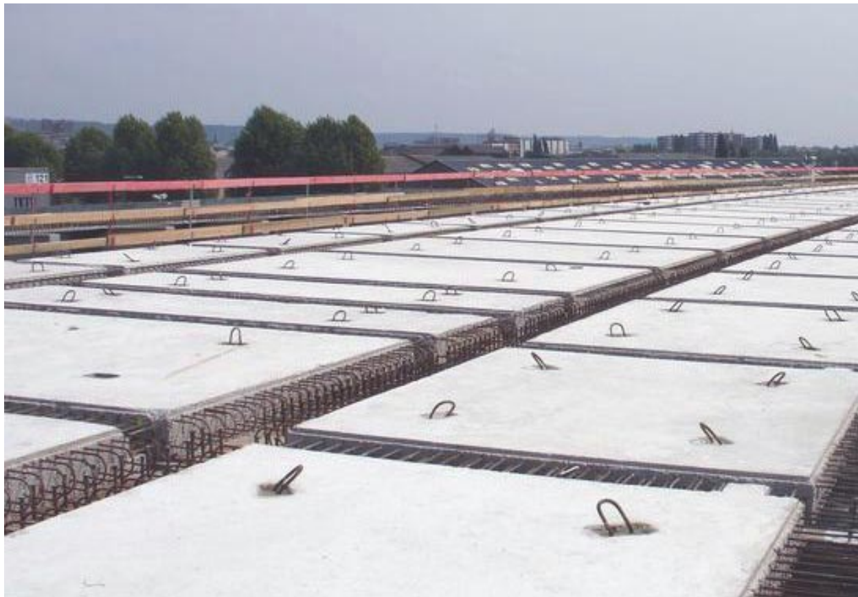
Construction de la dalle par éléments préfabriqués
