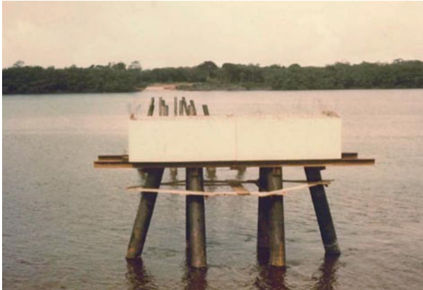
Figure 2 : Piles en cours de construction en 1975 source : CETE Normandie-Centre
