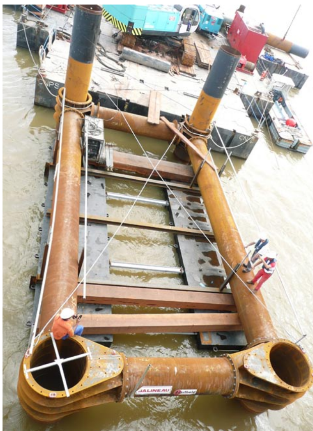
Figure 10 : Mise en œuvre des pieux source : CETE Normandie-Centre
