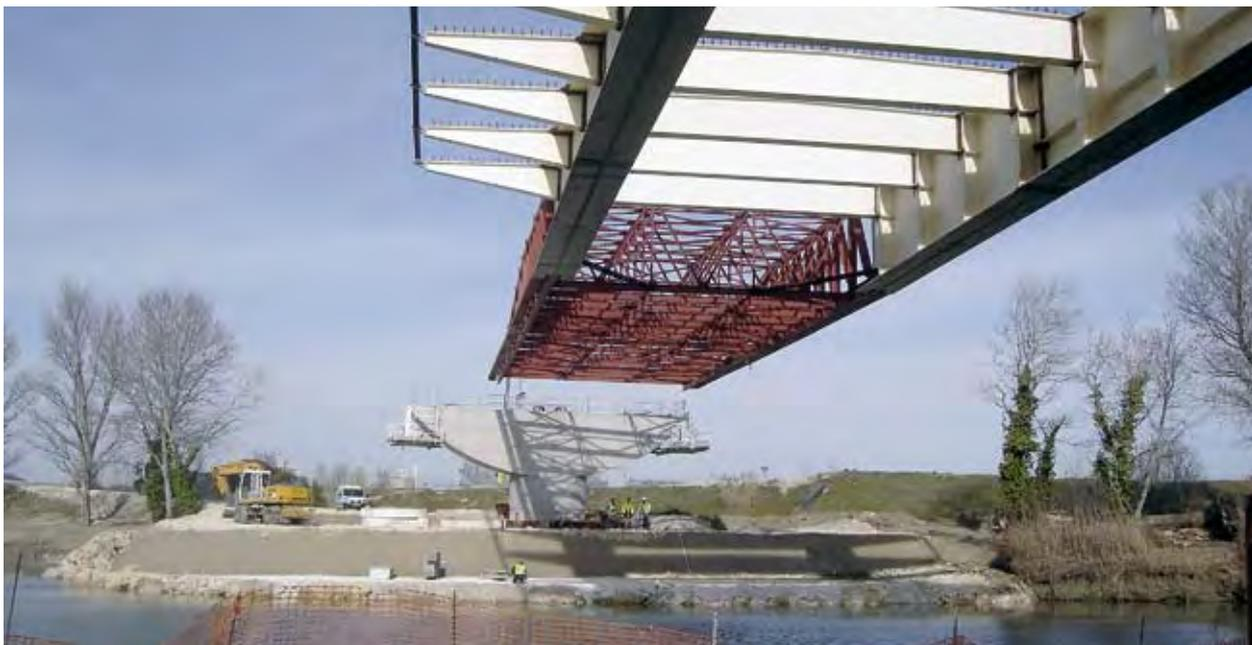
Photo 1 : charpente métallique en cours de lançage
