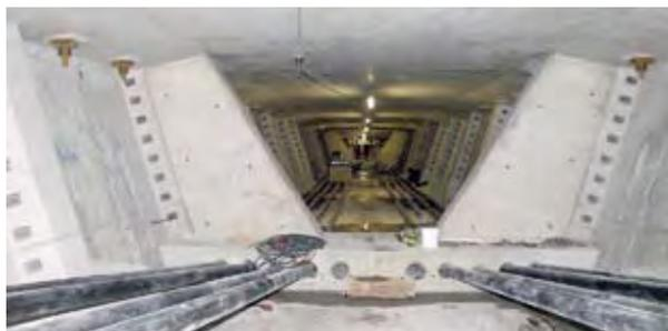
Figure 13 : vue de la précontrainte extérieure depuis l'intérieur du caisson – Source : CETE Nord-Picardie
