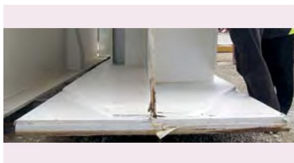
Photo 5 : extrémité d'une tôle additionnelle soudée sur la semelle inférieure
