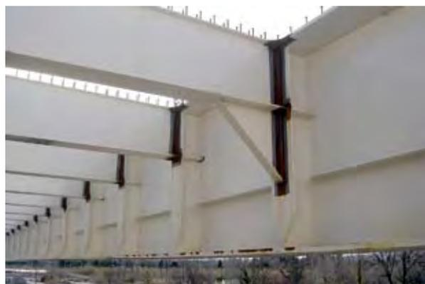
Photo 2 : renforcement de la pièce de pont à proximité d'un appui
