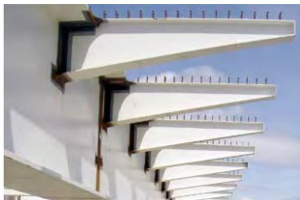
Photo 3 : consoles avant bétonnage de la dalle
