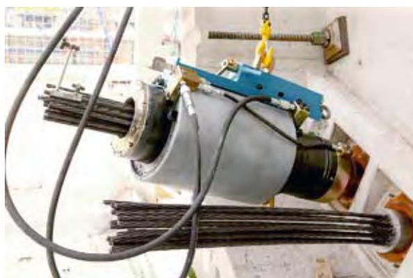
Photo 1: dispositif d'ancrage de précontrainte sur le chantier du viaduc de Compiègne – source : Gérard Forquet (Sétra)
