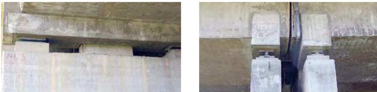
Figure 9 : appareils d'appui fréquemment rencontrés sur les ouvrages de l'A24 (néoprènes et crémaillères) – Source : CETE Méditerranée, Sétra
