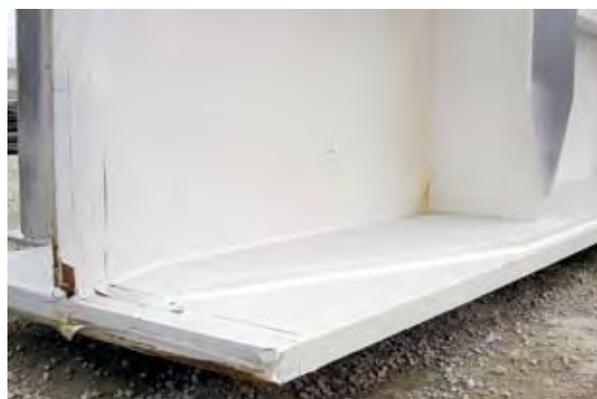
Photo 4 : extrémité de la tôle additionnelle soudée sur la semelle inférieure
