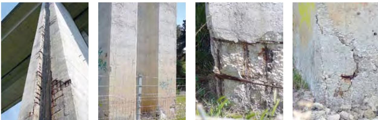
Figure 10 : pont 1 de l'A24, éclatement du béton d'enrobage – Source : CETE Méditerranée, Sétra
