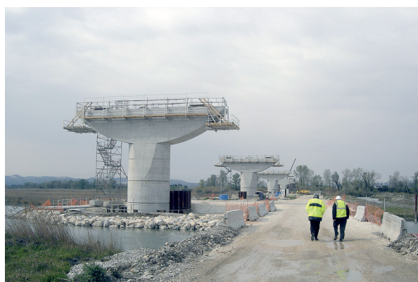
Photo 3 : piles en rivière – Source : Fernando Dias (Sétra)
