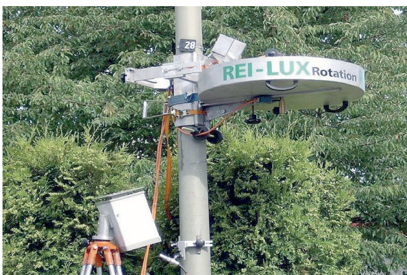
Photo 10 : contrôle potence ou grand mât – Source : REI-LUX
