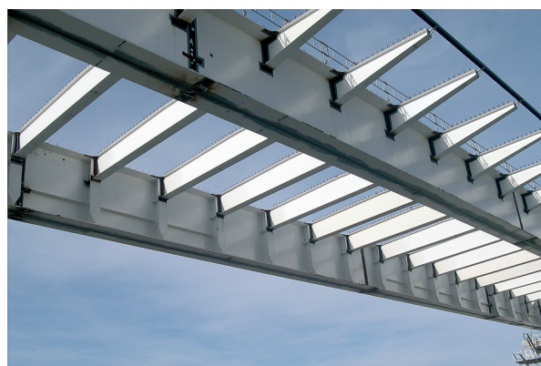
Photo 11 : pièces de pont et consoles – Source : Fernando Dias (Sétra)
