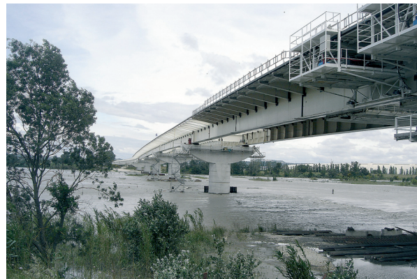
Photo 1 : crue de la Durance en juin 2008 - niveau de l'eau à 18,00 NGF - Source : Fernando Dias (Sétra)
