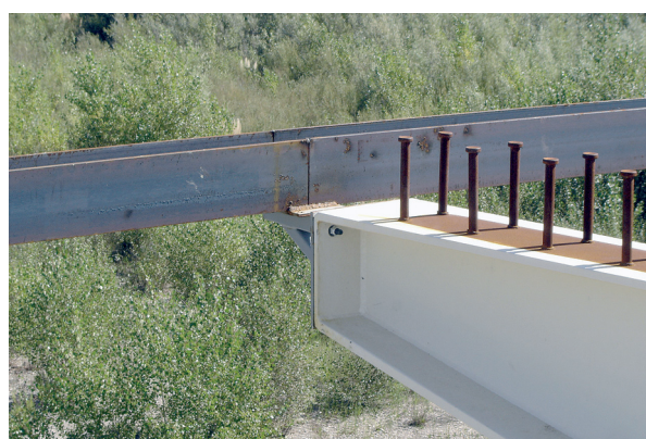
Photo 12 : plat en bout de console – Source : Fernando Dias (Sétra)
