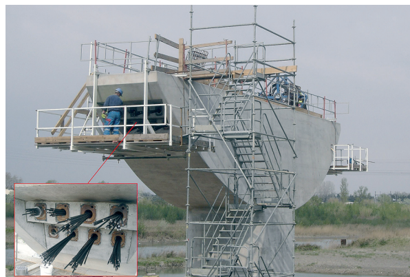
Photo 7 : précontrainte du chevêtre d'une pile en rivière Source : Fernando Dias (Sétra)
