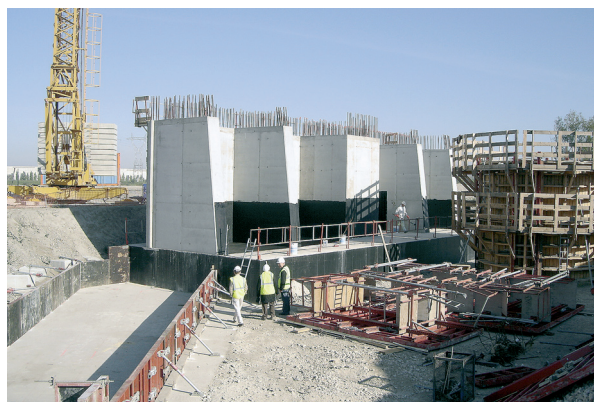
Photo 4 : semelle et voiles de la culée C10 – Source : Fernando Dias (Sétra)
