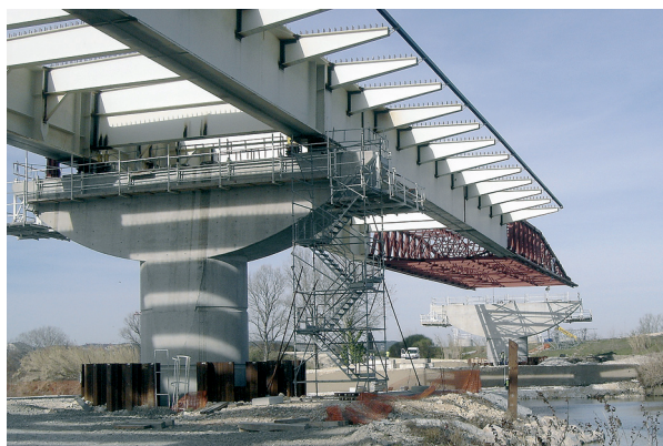
Photo 13 : fin du lancement de la charpente métallique Source : Fernando Dias (Sétra)
