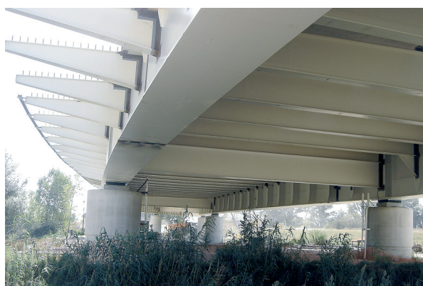
Photo 5 : piles en rive droite – Source : Fernando Dias (Sétra)
