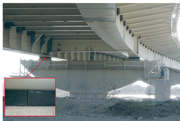
Photo 8 : appareils d'appui en élastomère fretté sur la pile la pile P4 Source : Fernando Dias (Sétra)
