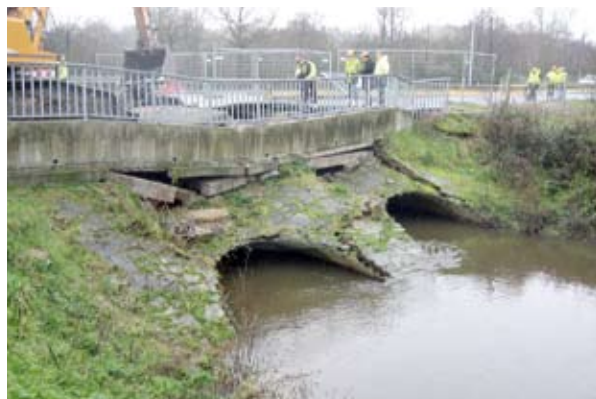
Photos 2 : effondrement suite à la construction d'une chaussée neuve côté amont pour remplacement de l'ouvrage en deux phases – Source : Jacques Billon (CETE de l'Ouest)
