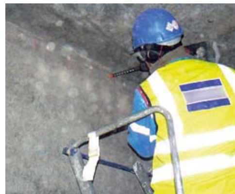
Photo 9 : forage aux emplacements des chevilles de fixation des plats métalliques – Source : LRPC d'Autun
