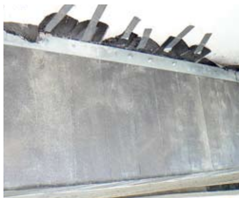
Photo 16 : mise en place des plats métalliques – Source : LRPC d'Autun
