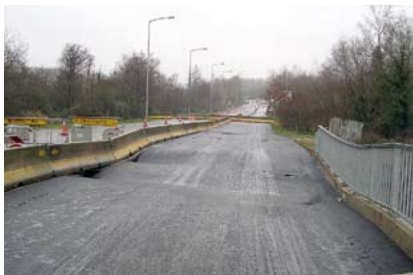
Photos 2 : effondrement suite à la construction d'une chaussée neuve côté amont pour remplacement de l'ouvrage en deux phases – Source : Jacques Billon (CETE de l'Ouest)
