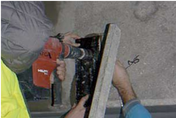
Photo 19 : préparation d'un essai de traction sur béton Source : LRPC d'Autun
