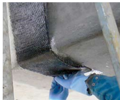
Photo 12 : pose de la première couche de TFC – Source : LRPC d'Autun
