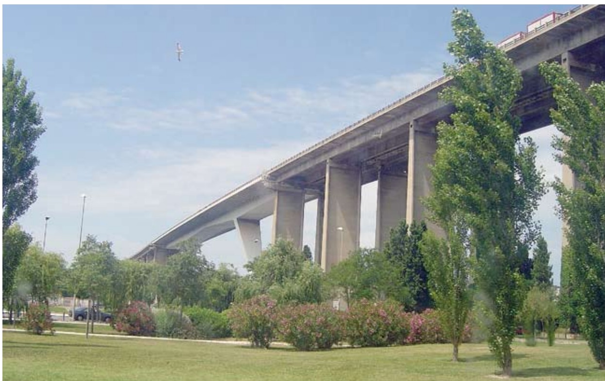
Photo 1 : vue des deux viaducs d'accès en béton et du tablier métal – Source : Denis Davi (CETE Méditerranée)
