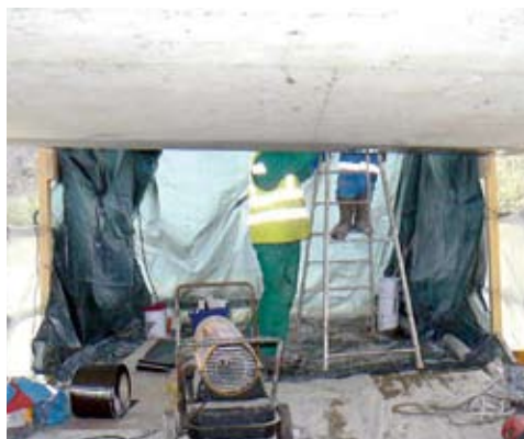
Photo 8 : chauffage de la zone de travail – Source : LRPC d'Autun
