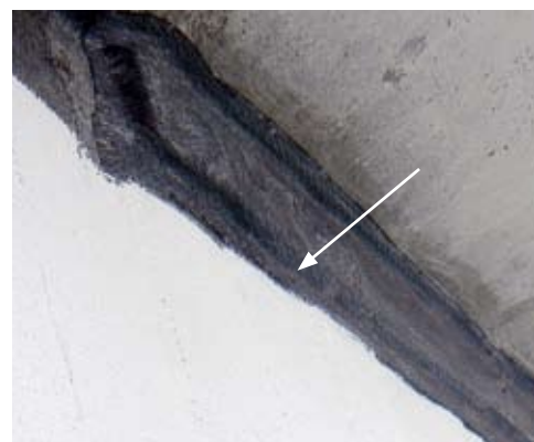
Photo 18 : collage d'une couche longitudinale supplémentaire de TFC de protection des plats – Source : LRPC d'Autun
