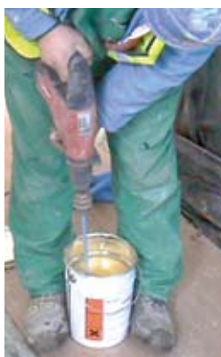
Photos 11 et 11a : application de la première couche de résine – Source : LRPC d'Autun
