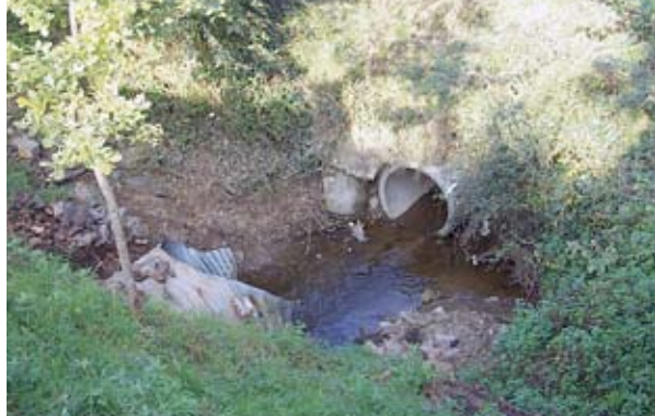
Photos 1 : soulèvement du radier de la buse à l'amont – Source : Jacques Billon (CETE de l'Ouest)
