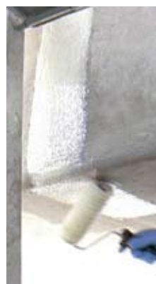
Photos 11 et 11a : application de la première couche de résine – Source : LRPC d'Autun
