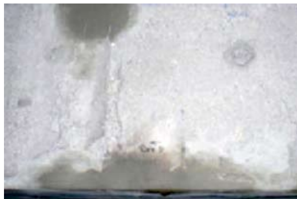
Photo 6 : réparation de surface du béton – Source : LRPC d'Autun
