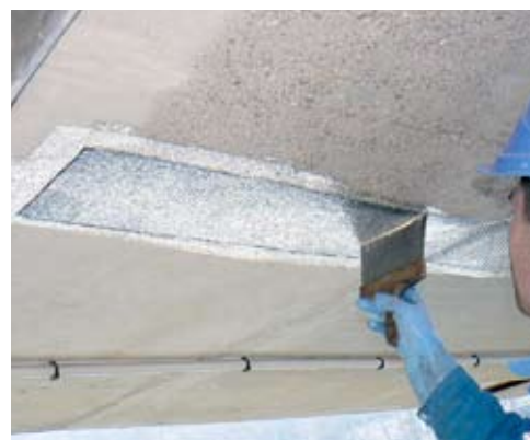
Photo 15 : application de la couche de résine de fermeture – Source : LRPC d'Autun
