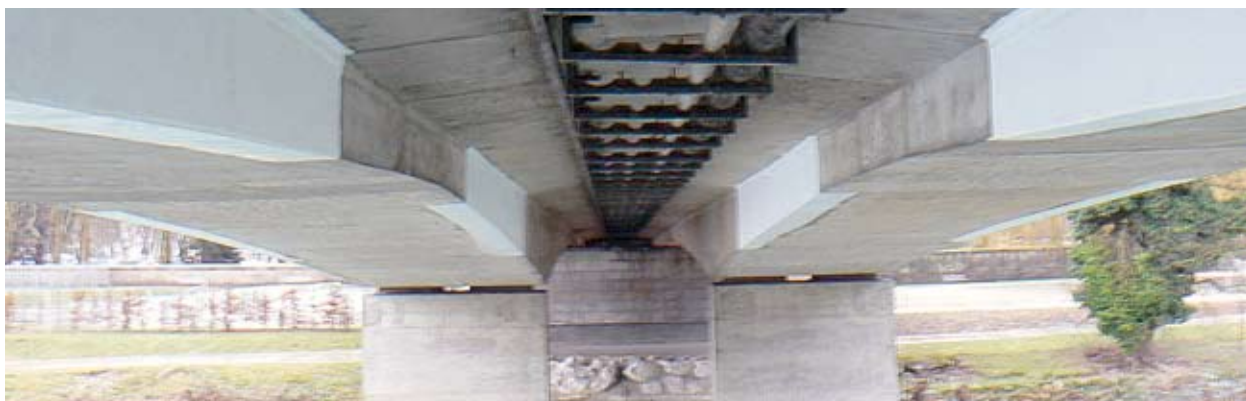
Photo 27 : chantier terminé – Source : LRPC d'Autun
