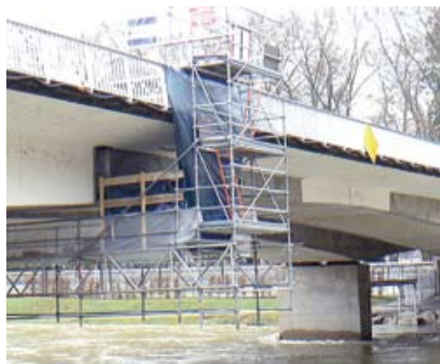
Photo 7 : vue de l'échafaudage mobile et du confinement de la zone de travail – Source : LRPC d'Autun
