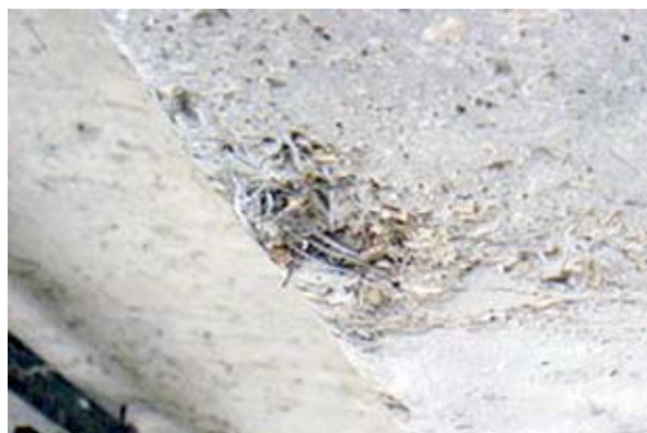
Photos 3 et 4 : préparation des surfaces par sablage à sec (dont élimination du revêtement de peinture sur les âmes extérieures du caisson) – Source : LRPC d'Autun
