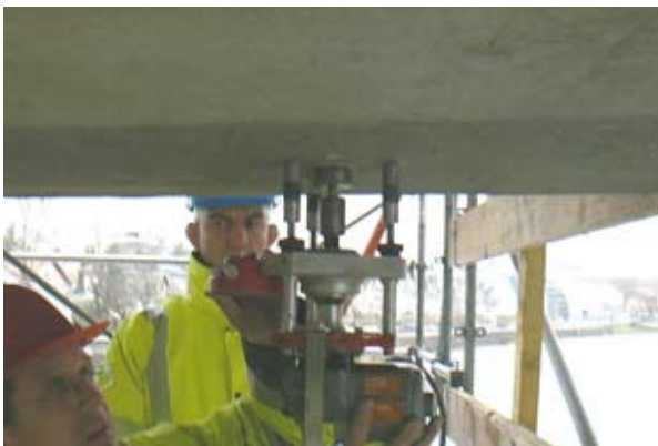
Photo 20 : exécution de traction sur béton (carottage à l'eau) Source : LRPC d'Autun
