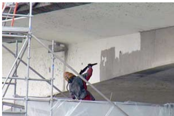
Photos 3 et 4 : préparation des surfaces par sablage à sec (dont élimination du revêtement de peinture sur les âmes extérieures du caisson) – Source : LRPC d'Autun
