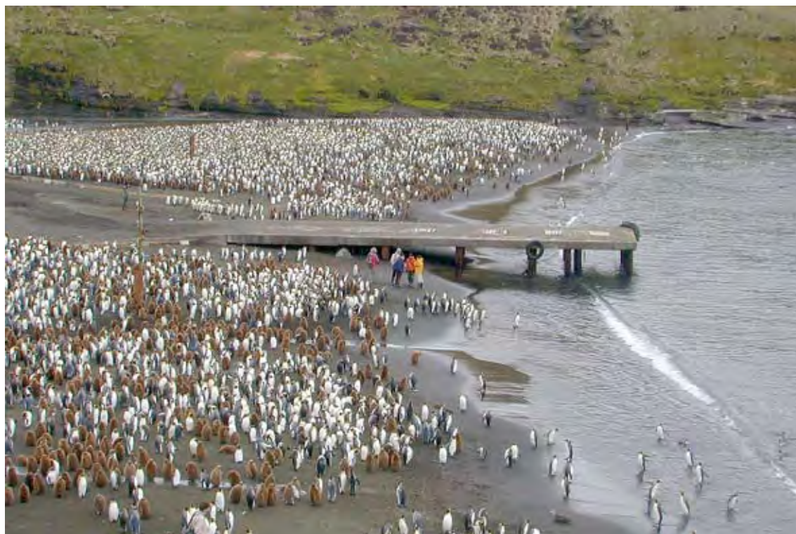
Photo 31 : vue générale de l'appontement avant réhabilitation. Été 2004 (hiver austral) – Source : TAAF
