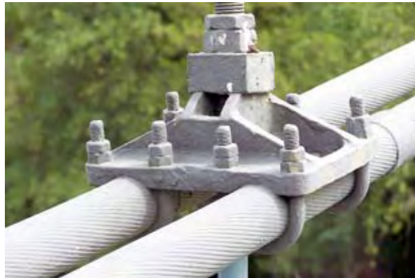
Photo 2 : nappe de deux câbles – Source : Patrick Losset (CETE du Sud-Ouest)
