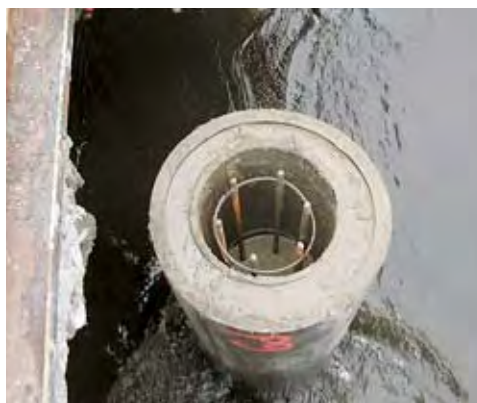
Photo 17 : bétonnage de l'espace annulaire – Source : TAAF
