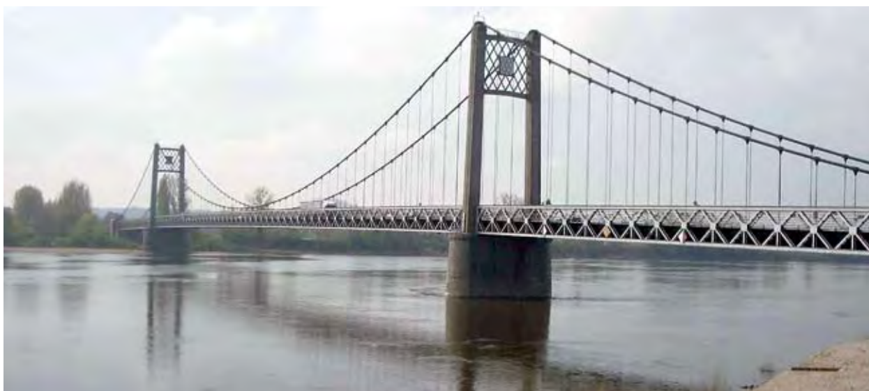
Photo 10 : pont Ancenis – Source : Patrick Losset (CETE du Sud-Ouest)
