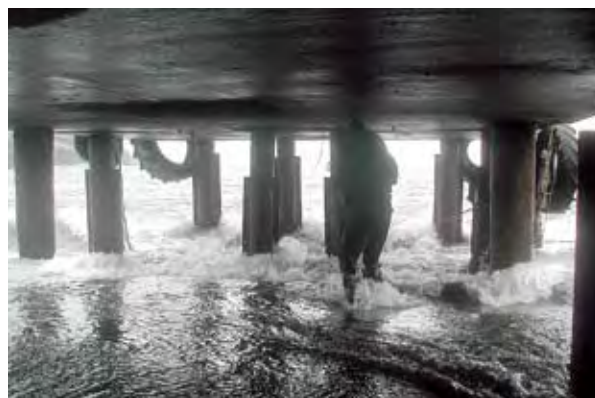
Photo 9 : vue de la sous-face du tablier – Source : CETMEF
