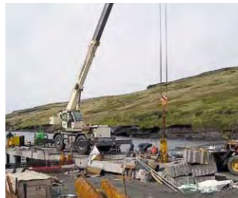
Photo 12 : vue générale du chantier de battage – Source : TAAF
