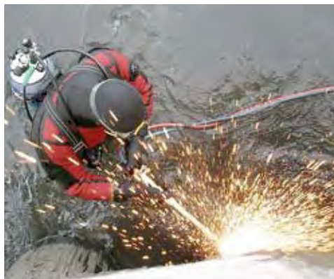
Photo 23 : découpage des anciens pieux – Source : TAAF
