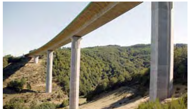
Viaducs du Piou et du Riulong – 1995
