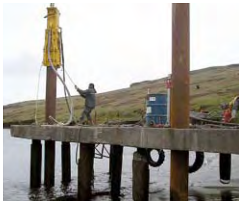
Photo 11 : battage d'un nouveau pieu – Source : TAAF
