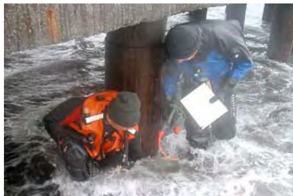
Photo 7 : réalisation de mesure d'épaisseurs résiduelles – Source : CETMEF
