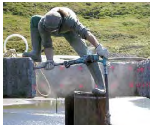
Photo 15 : forage des scellements horizontaux – Source : TAAF
