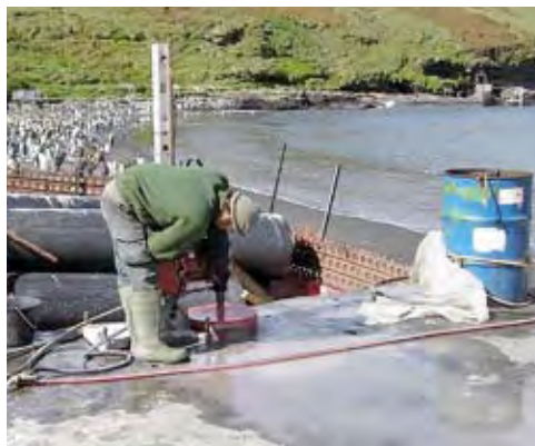
Photo 10 : carottage du tablier – Source : TAAF
