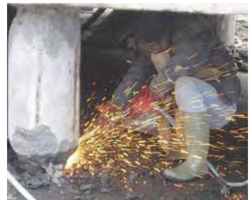
Photo 24 : découpage des anciens pieux – Source : TAAF
