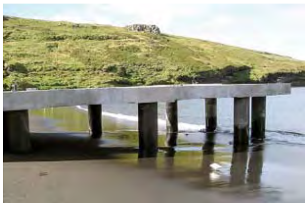
Photo 25 : appontement à la fin des travaux - Mars 2006
