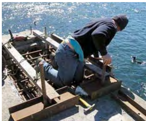
Photo 19 : positionnement du coffrage – Source : TAAF
