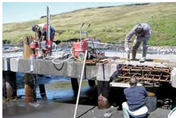
Photo 33 : vue du chantier – Source : TAAF
