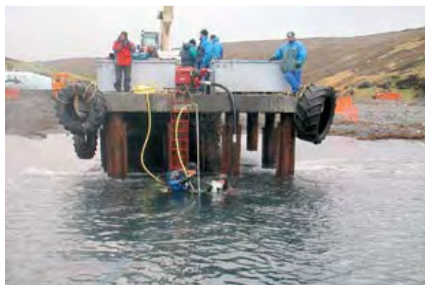
Photo 5 : utilisation de la lance à eau sous pression – Source : CETMEF
