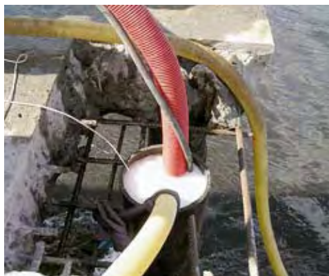
Photo 14 : curage d'un pieu – Source : TAAF
