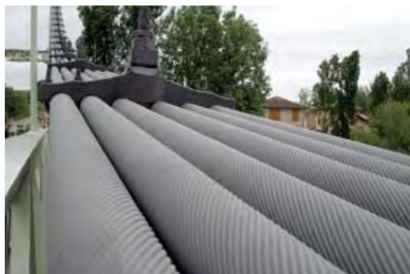
Photo 4 : nappe câbles en fils parallèles – Source : Patrick Losset (CETE du Sud-Ouest)
