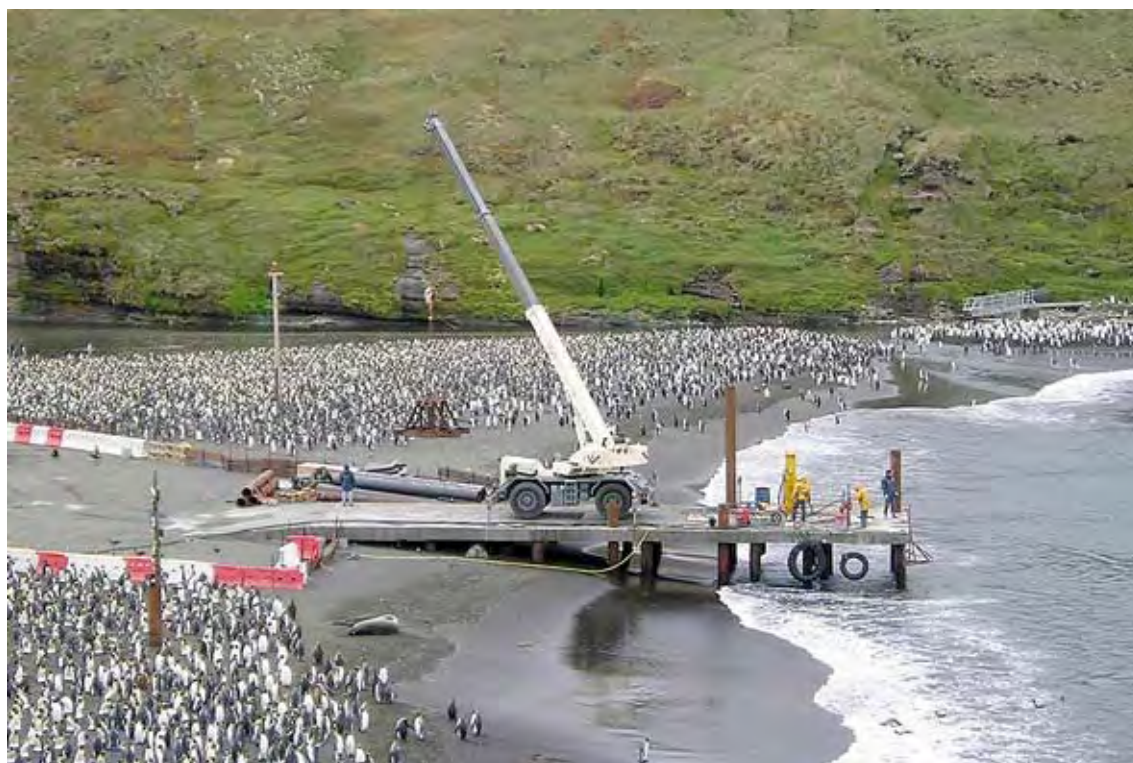
Photo 32 : vue générale des travaux de réhabilitation. Hiver 2006 (été austral) – Source : TAAF
