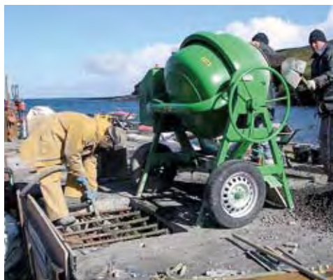
Photo 20 : bétonnage du pieu et du chevêtre – Source : TAAF
