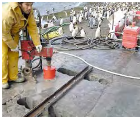
Photo 13 : découpage du tablier – Source : TAAF
