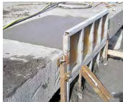
Photo 21 : pieu et chevêtre bétonné – Source : TAAF
