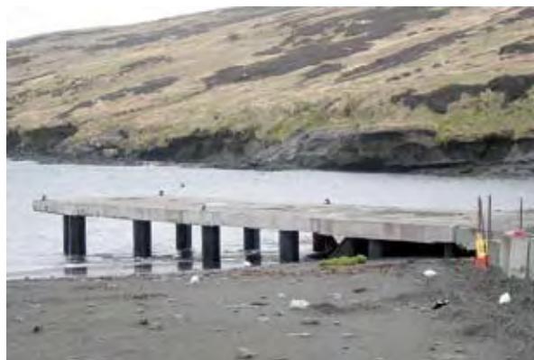
Photo 26 : appontement après environ 1 an de service - Août 2007
