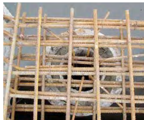
Photo 18 : scellements des aciers du chevêtre – Source : TAAF
