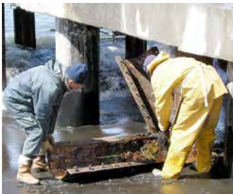
Photo 22 : suppression des ½ coquilles – Source : TAAF
