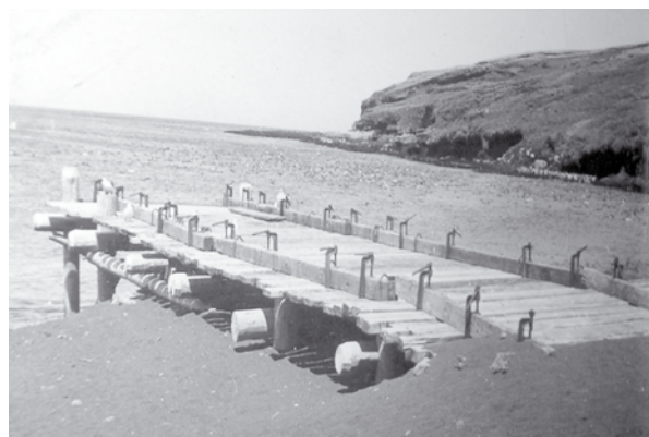
Photo 1 : ancien wharf entièrement en bois – Source : TAAF
