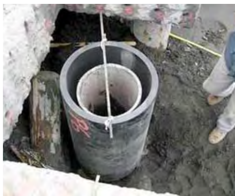
Photo 16 : virole PEHD \phi 630 épais 30 mm – Source : TAAF
