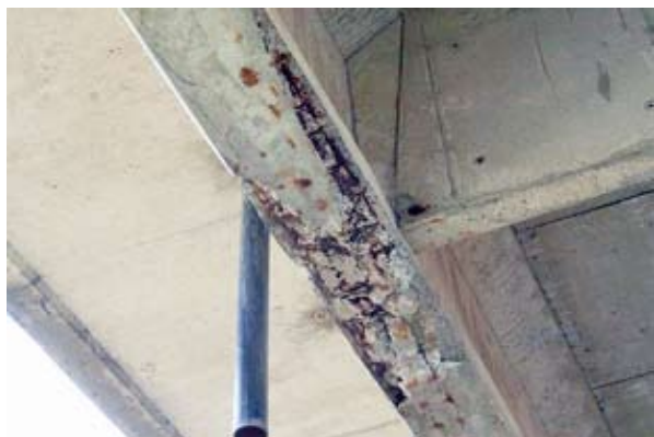
Photos 1a et 1b : exemples de dégradations induites par des phénomènes de corrosion des armatures liés à la présence de chlorures. Les chlorures proviennent de ruptures des tuyaux d'évacuations des avaloirs qui traversaient les poutres de rive, avant leur remplacement par des tuyaux avec évacuation directe – Source : Pierre-Marie Dubois, Daniel Michaux (PMD - ATEAV Systems)
