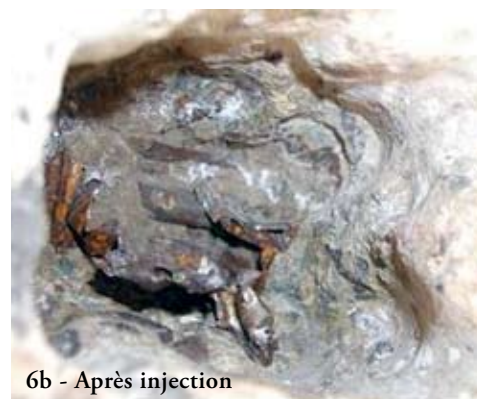
Photos 6a et 6b : observation, sur le terrain, de l'évolution d'aspect du coulis liée à l'imprégnation par la solution inhibitrice – Source : Pierre-Marie Dubois, Daniel Michaux (PMD - ATEAV Systems)
