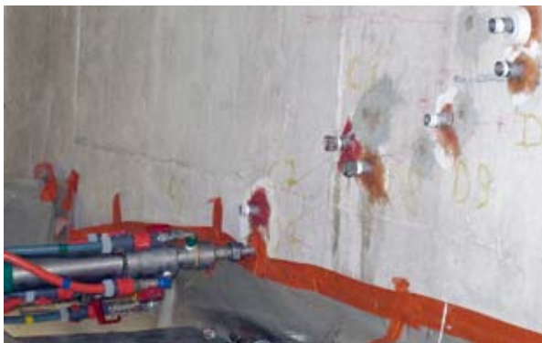
Photo 14 : injection d'un tronçon situé entre les caissons – Source : Pierre-Marie Dubois, Daniel Michaux (PMD - ATEAV Systems)
