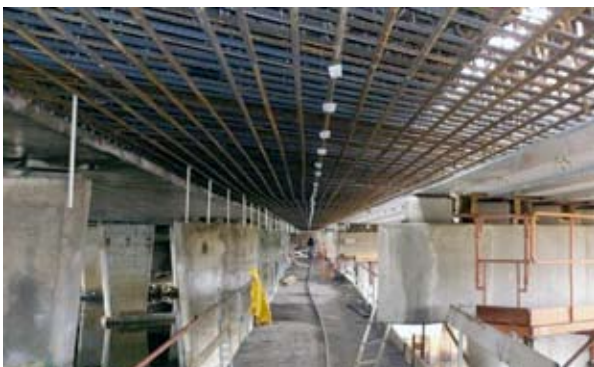
Photo 4 : le ferrailage de l'encorbellement négatif
