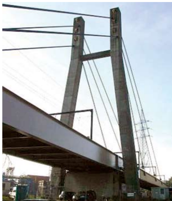
Photo 8 : pont haubané de Marchienne-au-Pont – Source : Pierre-Marie Dubois, Daniel Michaux (PMD - ATEAV Systems)
