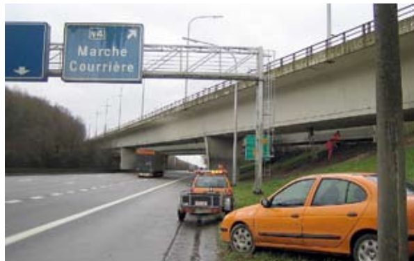
Photo 15 : viaducs de Courrière – Source : Pierre-Marie Dubois, Daniel Michaux (PMD - ATEAV Systems)
