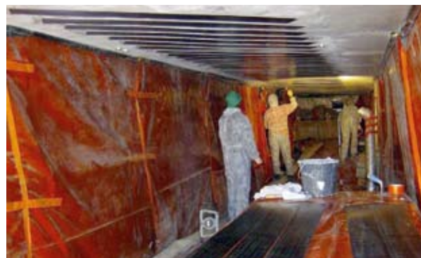
Photo 6 : pose des lamelles de fibre de carbone. Les conditions météo et hydriques n'étant pas bonnes (travaux effectués en hiver et ouvrage situé au-dessus d'une rivière) l'entreprise a travaillé dans « un tunnel » avec chauffage, tant pour le séchage de la résine que préalablement pour la mise en température du béton, plusieurs heures avant toute pose) – Source : Hervé Marneffe (CETE de l'Est)
