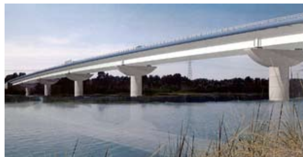
Figure 1 : vue générale de l'ouvrage en Durance – Source : CETE Méditerranée
