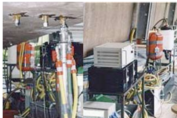
Photo 4 : injection de la solution inhibitrice au moyen du transducteur ultrasonore – Source : Pierre-Marie Dubois, Daniel Michaux (PMD - ATEAV Systems)
