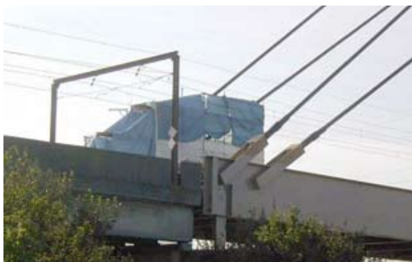
Photo 9 : zone de traitement au niveau des culots d'ancrage – Source : Pierre-Marie Dubois, Daniel Michaux (PMD - ATEAV Systems)
