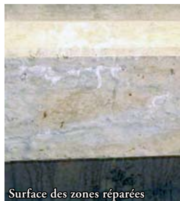
Photos 23 : observation des poutres réparées en septembre 2007 : aucune évolution d'aspect indiquant une possible reprise des activités de corrosion n'a été constatée – Source : Pierre-Marie Dubois, Daniel Michaux (PMD - ATEAV Systems)
