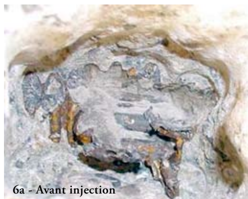
Photos 6a et 6b : observation, sur le terrain, de l'évolution d'aspect du coulis liée à l'imprégnation par la solution inhibitrice – Source : Pierre-Marie Dubois, Daniel Michaux (PMD - ATEAV Systems)
