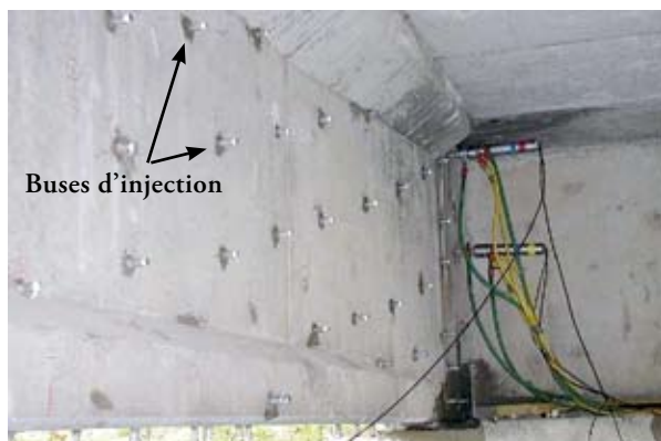
Photo 3 : béton précontraint en cours de traitement après perçage et mise en place des buses d'injection – Source : Pierre-Marie Dubois, Daniel Michaux (PMD - ATEAV Systems)
