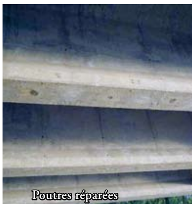
Photos 23 : observation des poutres réparées en septembre 2007 : aucune évolution d'aspect indiquant une possible reprise des activités de corrosion n'a été constatée – Source : Pierre-Marie Dubois, Daniel Michaux (PMD - ATEAV Systems)
