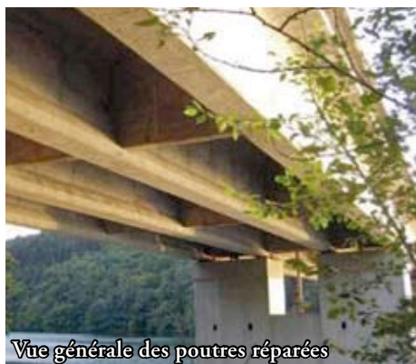
Photos 23 : observation des poutres réparées en septembre 2007 : aucune évolution d'aspect indiquant une possible reprise des activités de corrosion n'a été constatée – Source : Pierre-Marie Dubois, Daniel Michaux (PMD - ATEAV Systems)
