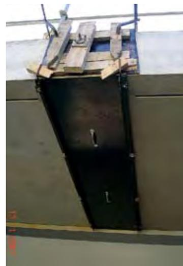
Photo 12 : coffrage en contreplaqué des clavages du hourdis en encorbellement
