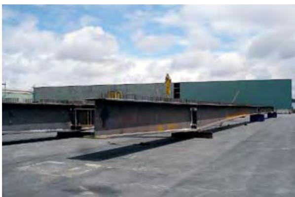
Photo 6 : montage à blanc de la charpente métallique en usine (Tronçons 1-2-3) – Source : Philippe Vion (Sétra)
