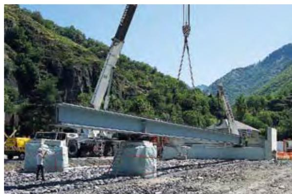
Photo 7 : pose du tronçon C4-P3 amont à la grue – Source : Michel Boileau (DIR SO)
