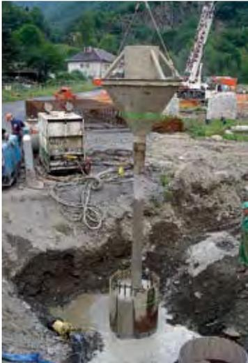
Photo 3b : bétonnage des pieux de la pile P2 – Source : Michel Boileau (DIR SO)
