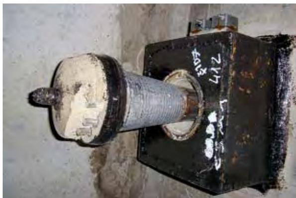
Photo 8 : démontage des ancrages – Source : RST
