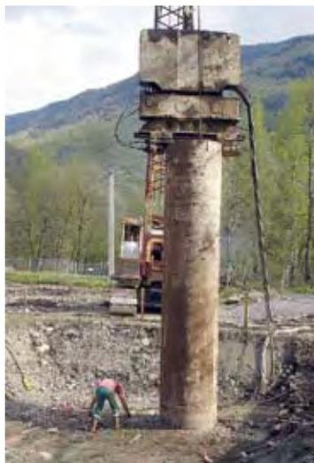
Photo 2 : mise en œuvre des tubes des pieux de la pile P2 – Source : Michel Boileau (DIR SO)
