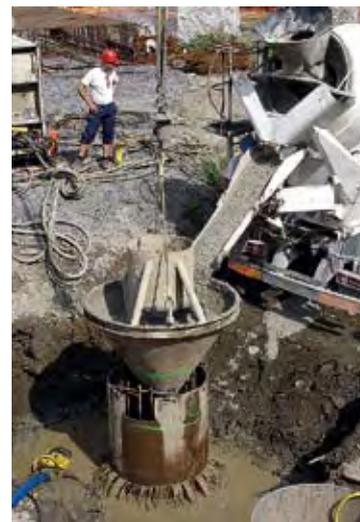
Photos 3a : bétonnage des pieux de la pile P2 – Source : Michel Boileau (DIR SO)
