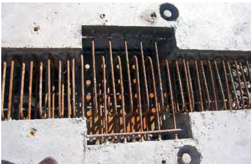
Photo 10 : lumières de connexion et joint de clavage – Source : Philippe Vion (Sétra)
