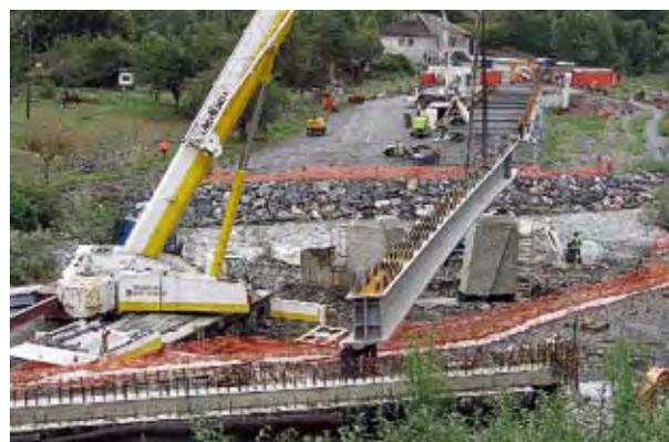
Photo 9 : pose du tronçon C0-P1 amont à la grue – Source : Michel Boileau (DIR SO)
