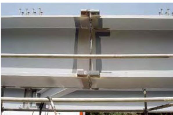
Photo 8 : préparation des tronçons adjacents avant soudure – Source : Philippe Vion (Sétra)
