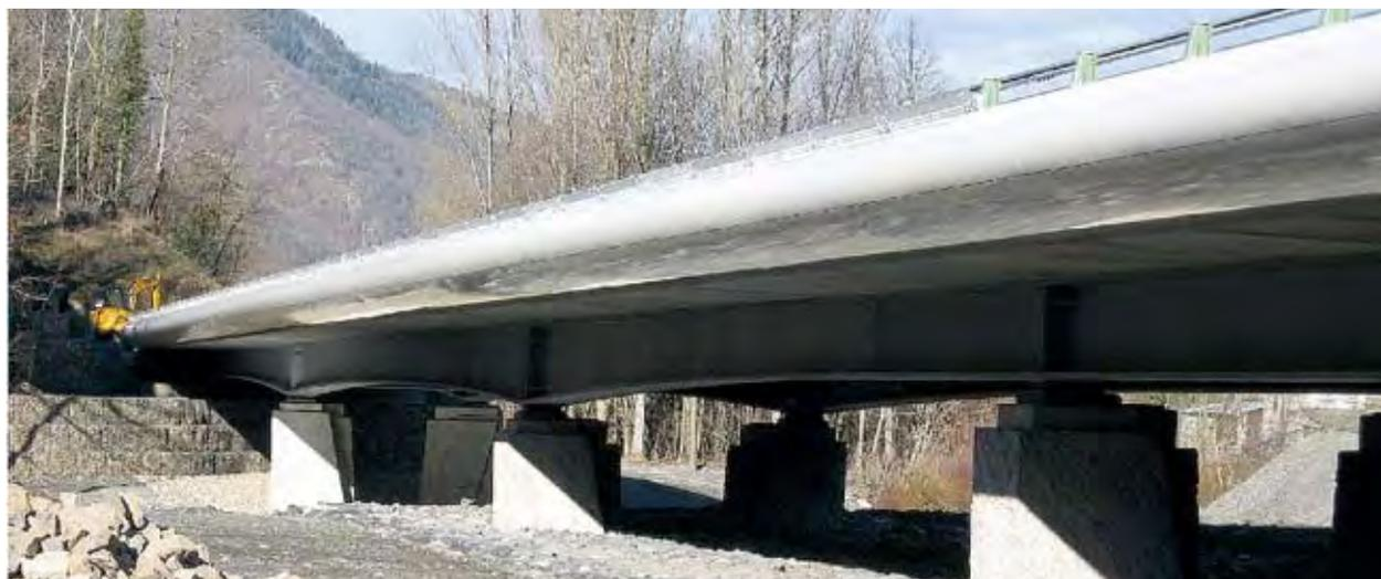
Photo 13 : ouvrage avec ses corniches-caniveaux – Source : Michel Boileau (DIR SO)
