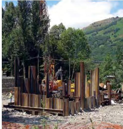
Photo 5 : réalisation du batardeau de la pile P1
