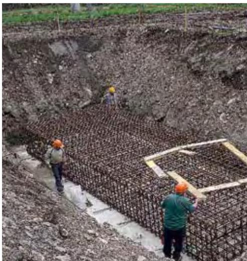
Photo 1 : réalisation de la semelle de la pile P3
