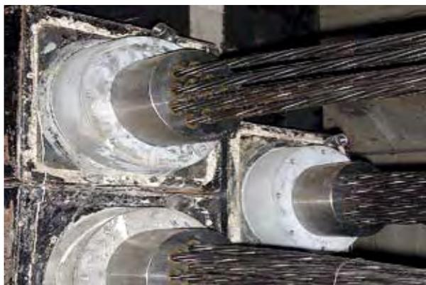
Photos 11 et 12 : réutilisation des plaques d'ancrage et surlongueurs aux abouts (avant pose du capot de protection) – Source : RST
