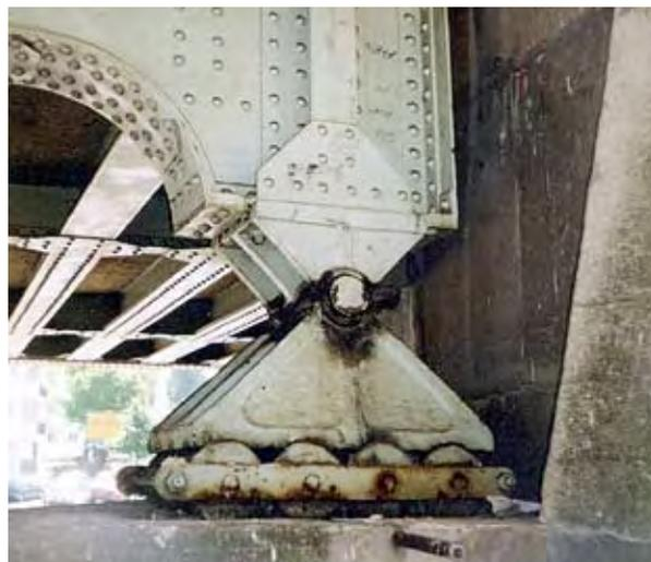
Photo 2 : plans de roulement douteux pour appareils à rouleaux multiples – Source : Yves Picard
