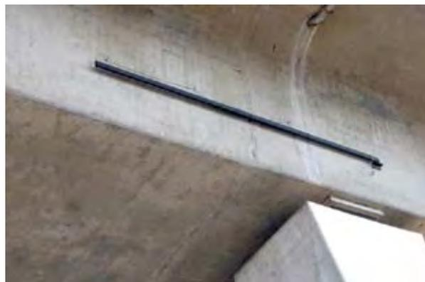
Photo 4 : exemple d'un courburemètre sur P3 – Source : Xavier Berdos (LRPC Nancy)
