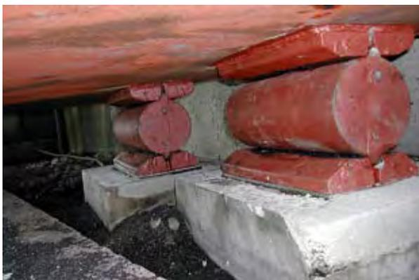
Photo 5 : appareils d'appui à rouleau simple après réfection, les surfaces de contact hertzien sont protégées par de la graisse, le balancier inférieur est posé sur un élastomère pour mieux absorber les rotations parasites transversales – Source : DREIF
