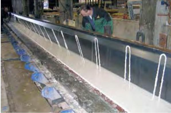
Photo 3 : mise en place de la partie supérieure du coffrage
