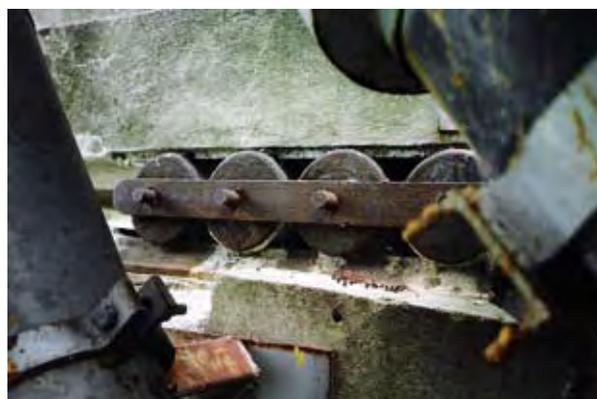
Photo 4 : plans de roulement très douteux pour appareils à rouleaux multiples, absence de possibilité de rotation – Source : Yves Picard
