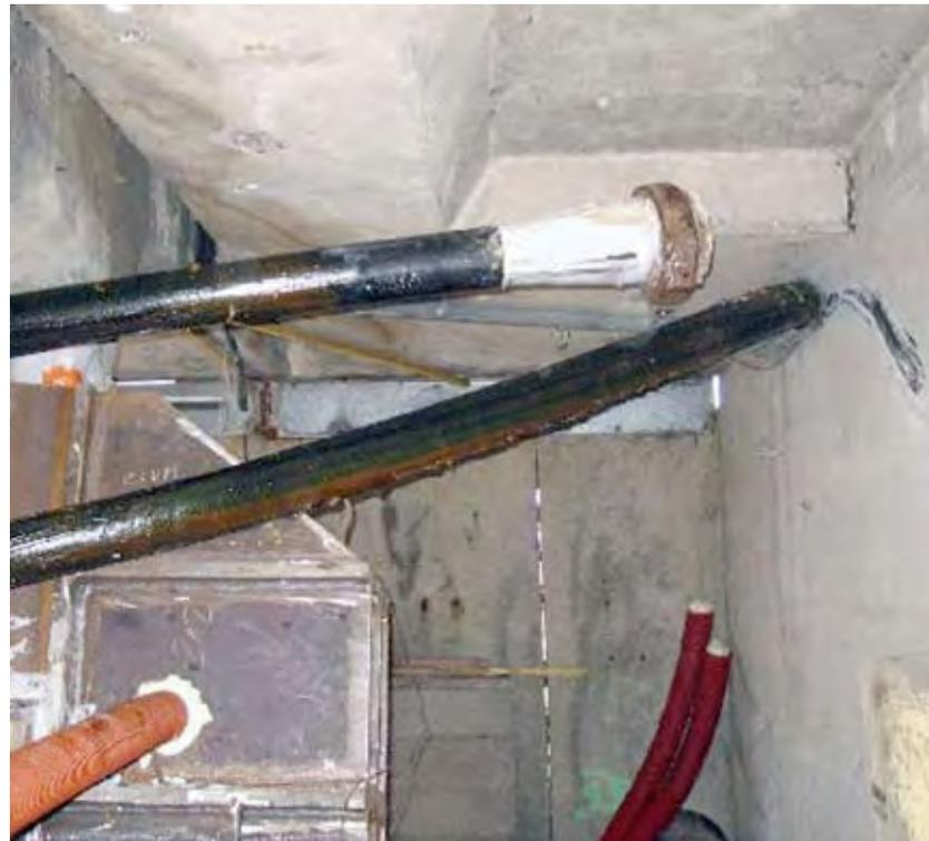
Photo 3 : vue d'une tête d'ancrage sur culée C8 – Source : Xavier Berdos (LRPC Nancy)
