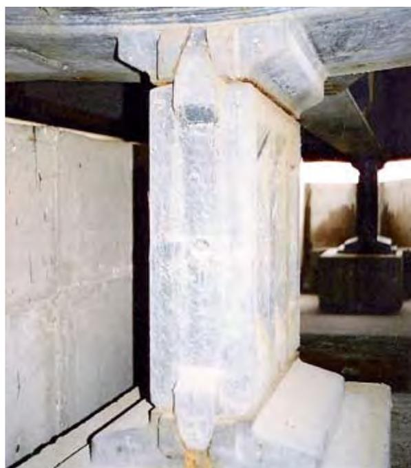
Photo 3 : plans de roulement d'un appareil à rouleau simple
