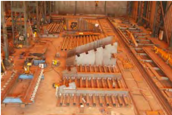
Photos 10 et 11 : fabrication des travées – Source : Véronique Martins (DDE 76)
