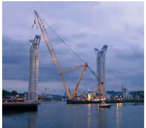
Photo 15 : pose 2 ème papillon – Source : Denis Leroy (DDE 76)
