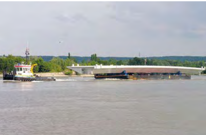
Photo 14 : remontée de la Seine d'un tablier – Source : Denis Leroy (DDE 76)
