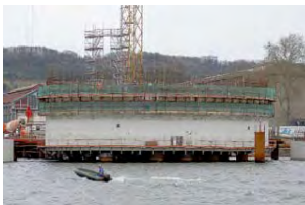
Photo 2 : coffrage glissant d'un socle – Source : Véronique Martins (DDE 76)
