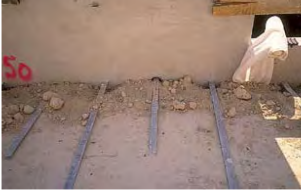
Photo 2 : exemple d'écaille équipée à l'origine de témoins de durabilité – Source : Sétra
