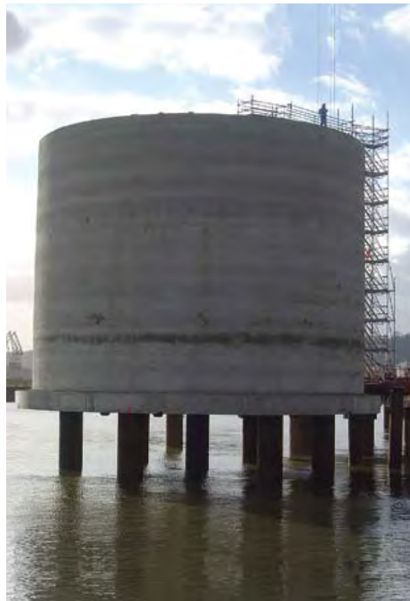
Photo 7 : gabion terminé reposant sur des gaines métalliques provisoires avant descente en fond de Seine – Source : Véronique Martins (DDE 76)
