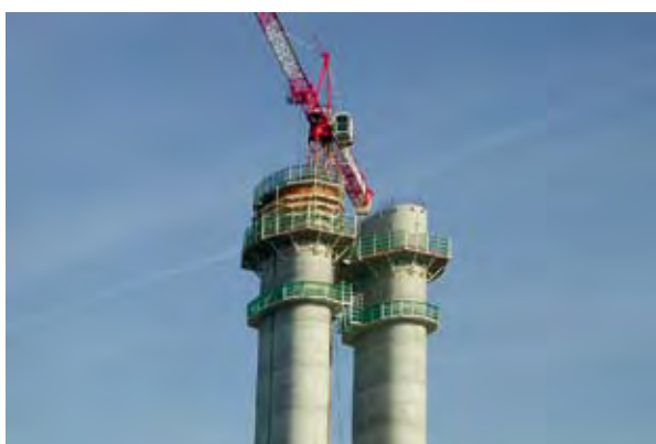
Photos 8 et 9 : réalisation des pylônes par coffrages grimpants – Source : Véronique Martins (DDE 76)
