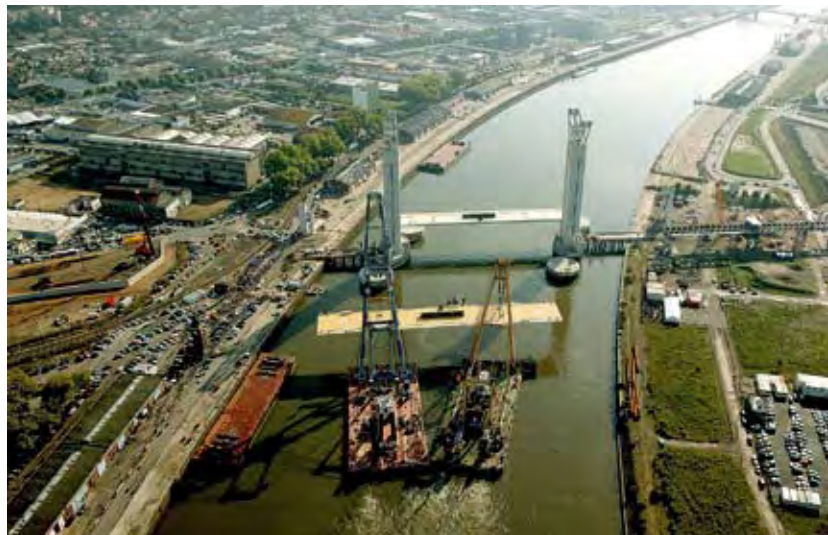
Photo 17 : pose de la 2 ème travée – Source : Gérard Forquet (Sétra)
