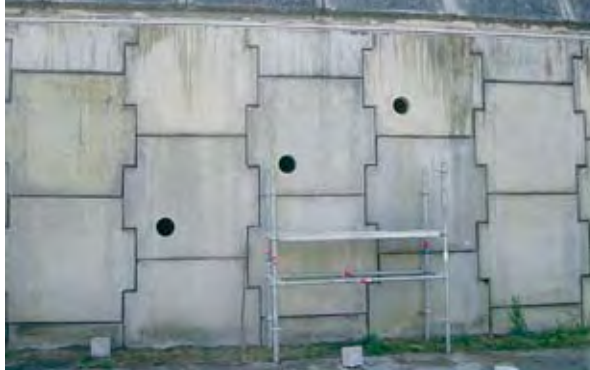
Photo 6 : implantation de carottages sur la hauteur d'un mur Source : L.R de Strasbourg
