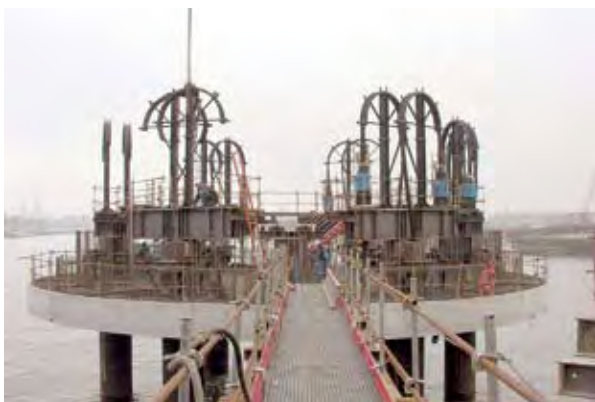
Photo 6 : installation du système de vérinage pour descente d'un gabion (avant réalisation des voiles latéraux) – Source : Véronique Martins (DDE 76)
