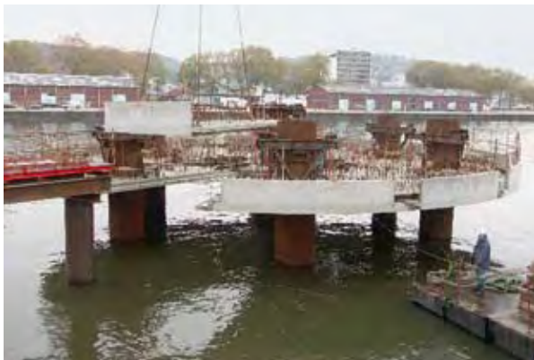
Photo 5 : pose d'un élément préfabriqué de radier de gabion Source : Véronique Martins (DDE 76)
