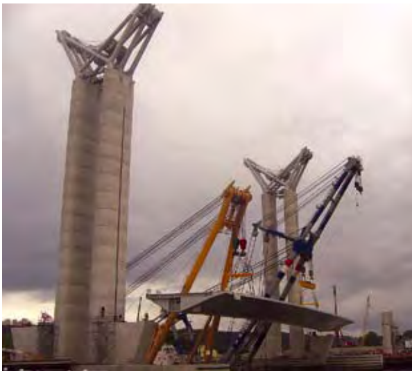
Photo 16 : pose de la 1 ère travée – Source : Denis Leroy (DDE 76)
