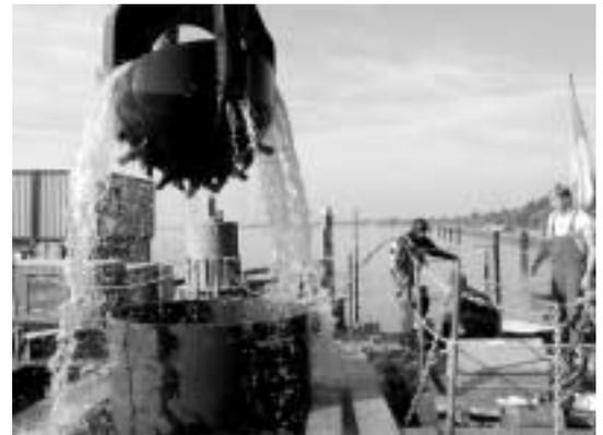
système de moufflage intégré au corps du grappin.
