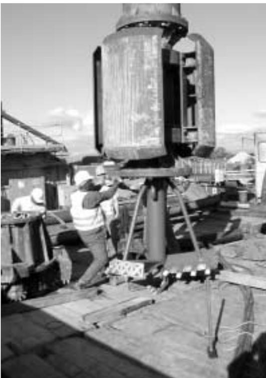
hydrostatiques de la nappe, une surcharge de bentonite est en permanence appliquée grâce à un tube-allonge d'environ 5 m de hauteur coiffant les chemises métalliques définitives Ø 1,80 m.
