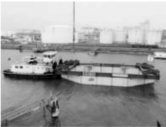
Quatre pieux provisoires Ø 700 mm sont alors vibrofoncés aux angles extérieurs du caisson. Un système de bagues coulissantes sur les pieux provisoires et sur le cadre métallique autorise un réglage en trois dimensions du caisson. Il ne reste plus qu'à immobiliser le caisson (par différentes opérations de soudage), à mettre le caisson en eau et à retirer les couvercles du radier en ayant recours à des plongeurs. Le vibrofonçage des chemises métalliques des pieux peut alors débuter.
