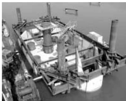
▲ Mise en place d'une chemise métallique.
