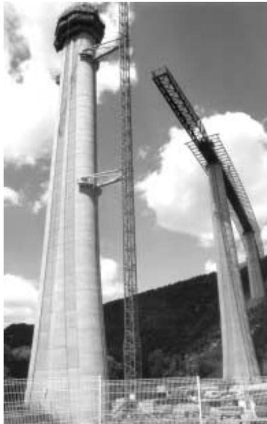
◀ Vue des grandes piles P2 et P3 : P2 terminée et P3 en cours de bétonnage.
