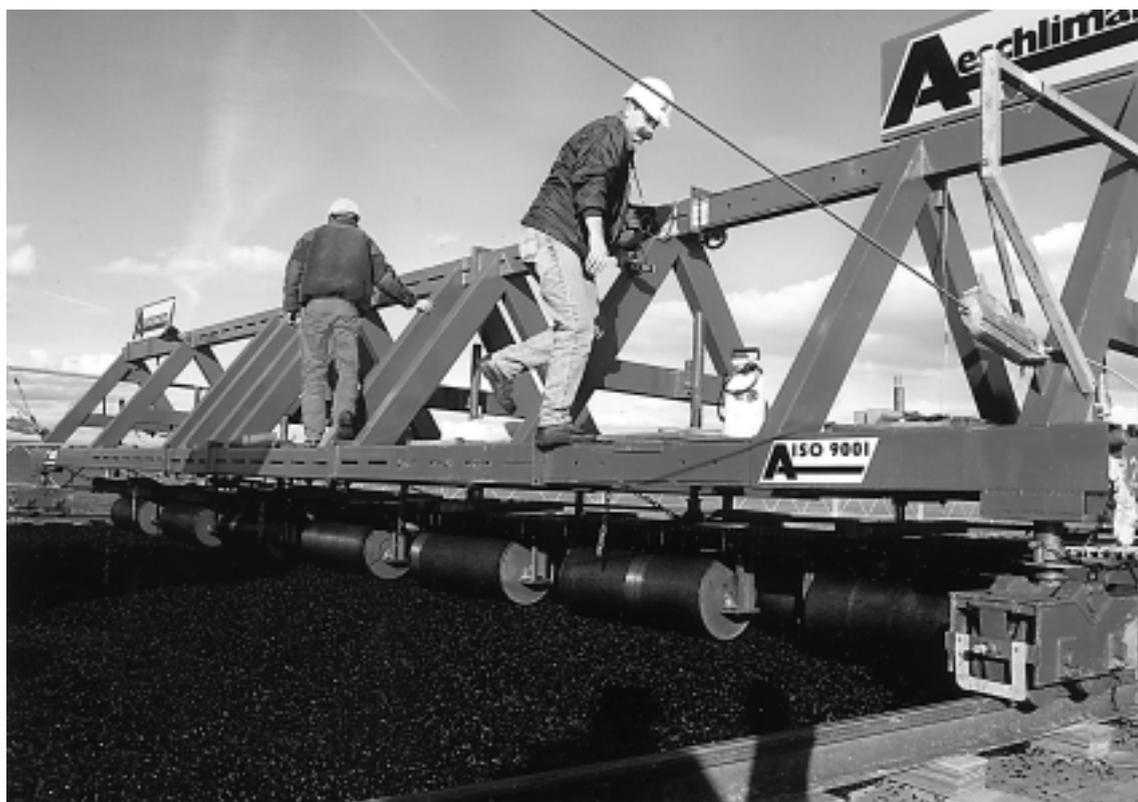
Poutre-support de cylindres pour incrustation, à pression variable, de gravillons de surfacage de revêtements de circulation en asphalte coulé.
