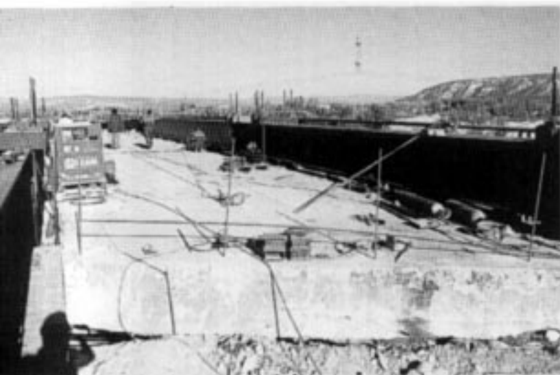
Vue des cintres de raidissage et de leurs barres de bridage
