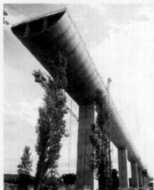
Viaduc de Vernègues
