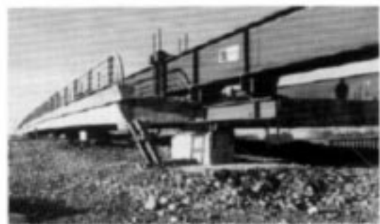
Accostage du tablier sur les marcheurs transférés de la pile P4 sur l'appui provisoire sur remblais. Vue générale de l'avant bec.
