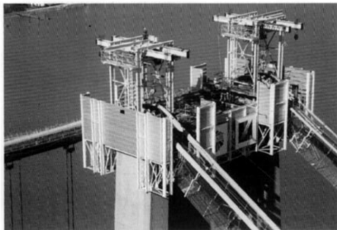
Modification des têtes de pylône
