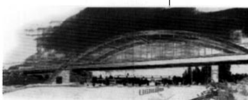
Franchissement du péage Sud d'Avignon, arc bow-string
