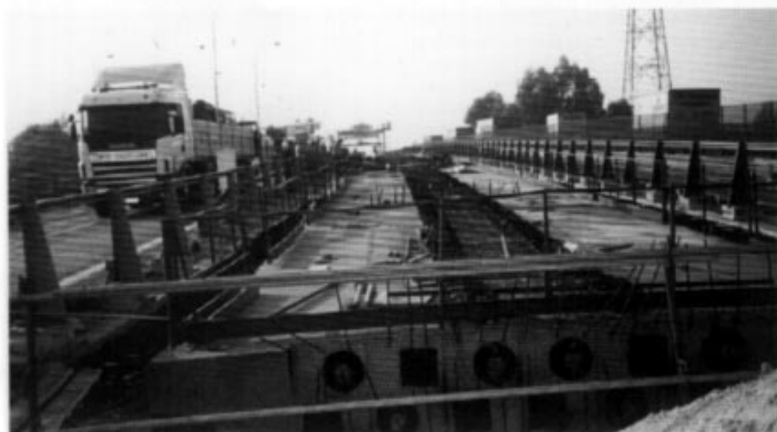
PSIDP Nord première phase coulé
