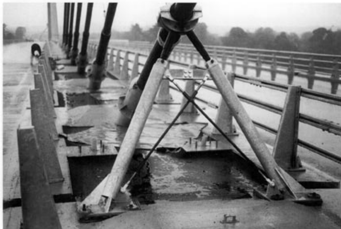
Exemple d'amortisseur en pied de hauban
