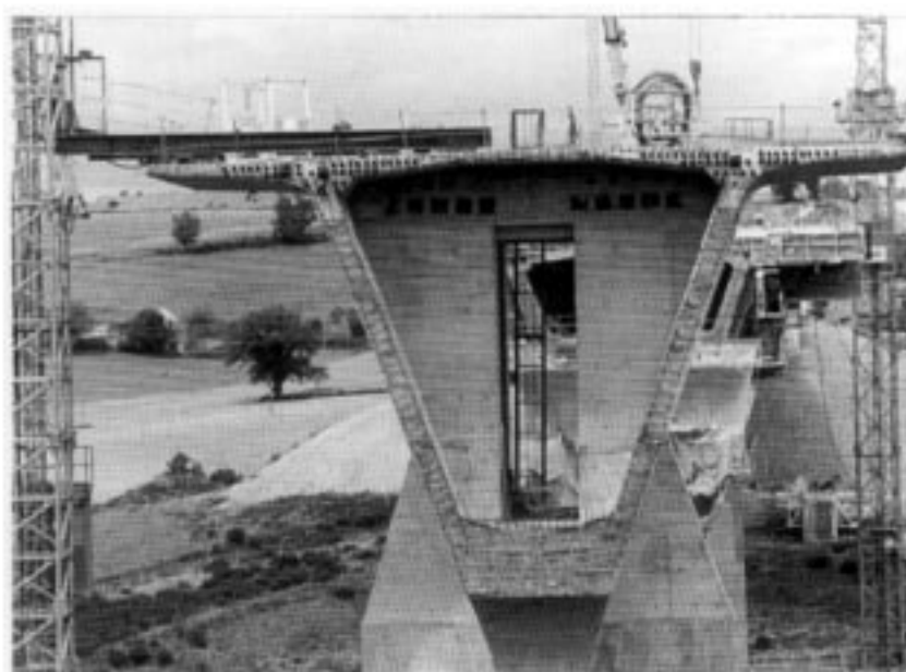
Les goussets du hourdis supérieur (photo G. Forquet - Setra)
