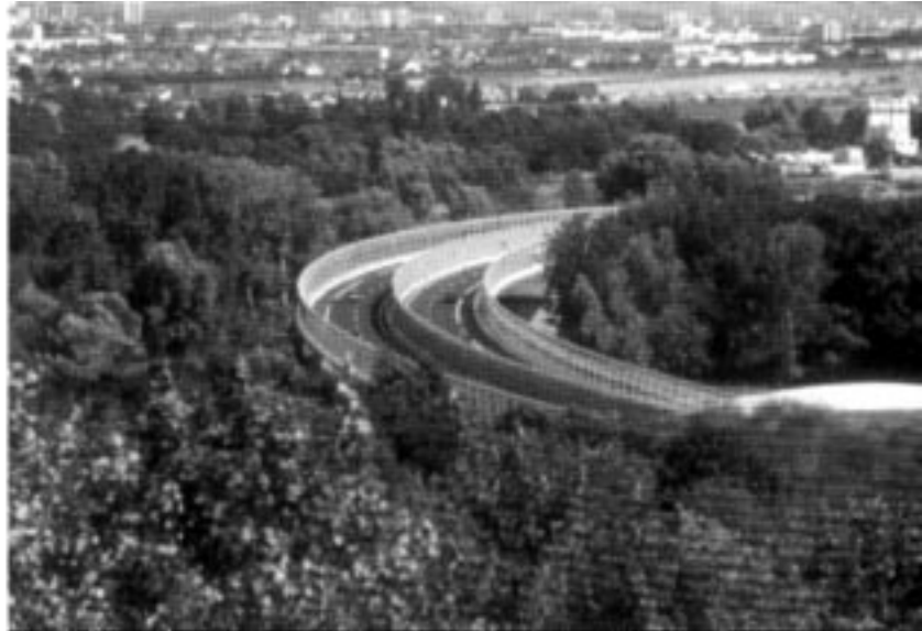
A14 - vue depuis la terrasse de St Germain en Laye (Photo SAPN / Claude ABRON).
