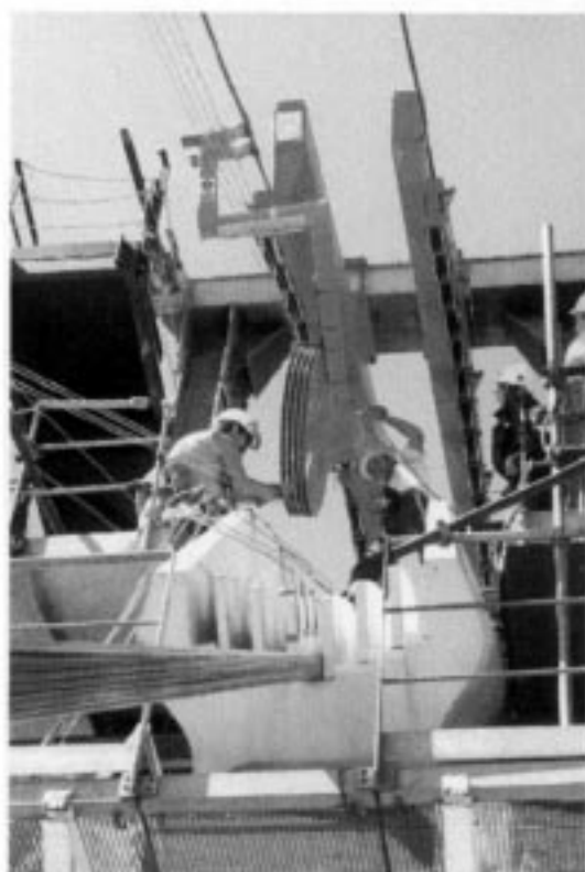
vail - montage /ajustement des câbles élémentaires - alternativement d'un câble à l'autre.
