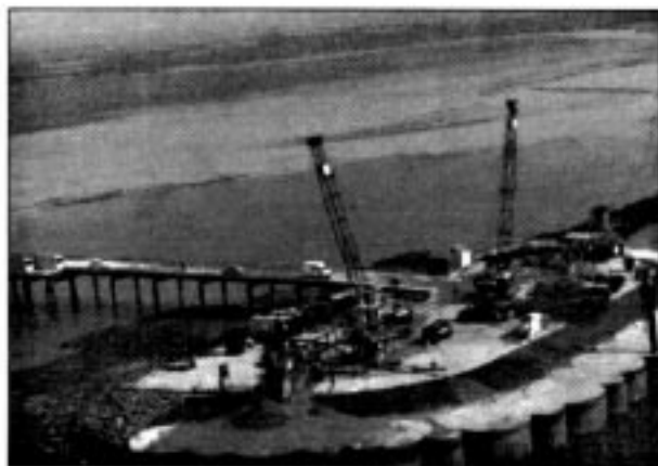
Le chantier de fondations profondes du pylône Nord sur l'île artificielle. Vue à marée basse. On distingue l'extrémité de l'estacade à gauche. Sur l'îlot : 2 grues, 2 cyclones de séparation de la boue, la foreuse WIRTH, les stocks de cages d'armatures.
