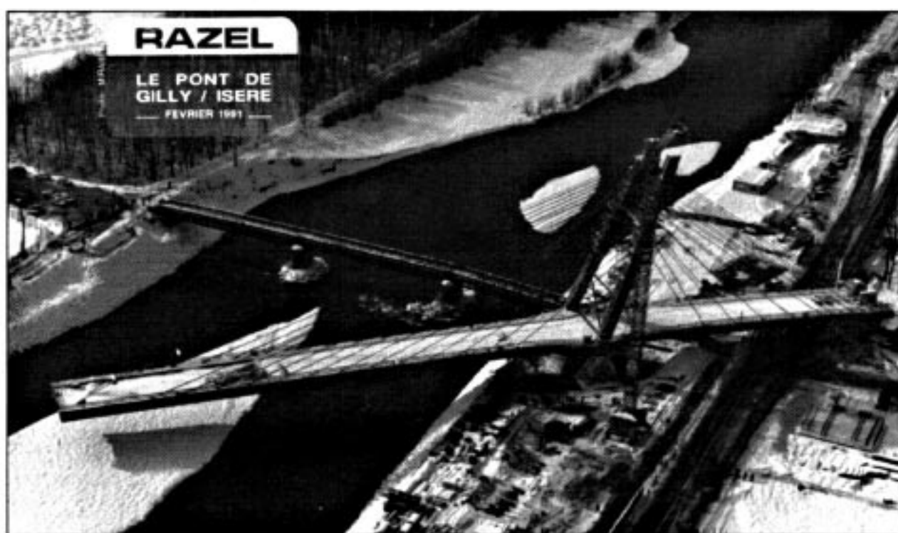
L'ouvrage en cours de rotation, le lundi 11 février 1991.
