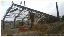
Friche avec une ancienne halle industrielle
