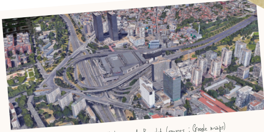
Vue aérienne de l'échangeur de Bagnolet. (sources : Google maps)
