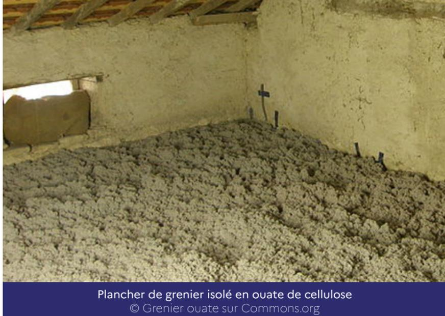
Plancher de grenier isolé en ouate de cellulose
