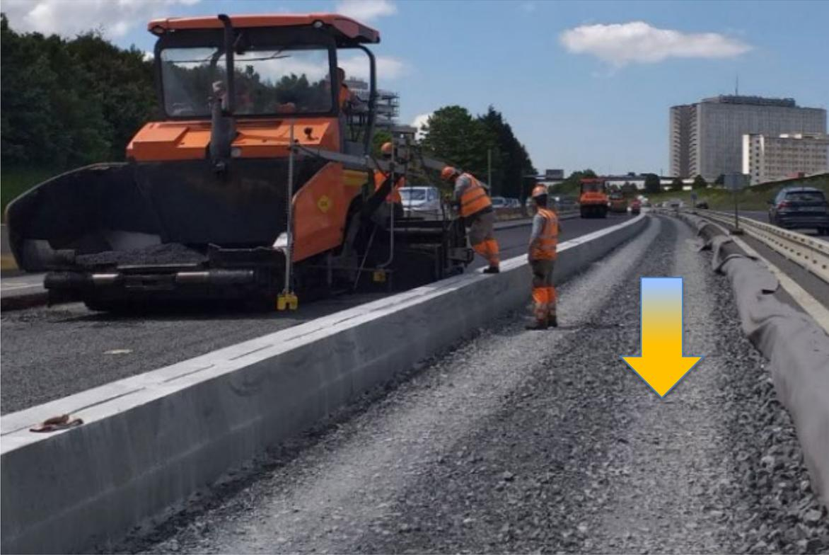
Essai de portance avant la mise en œuvre des Enrobés
