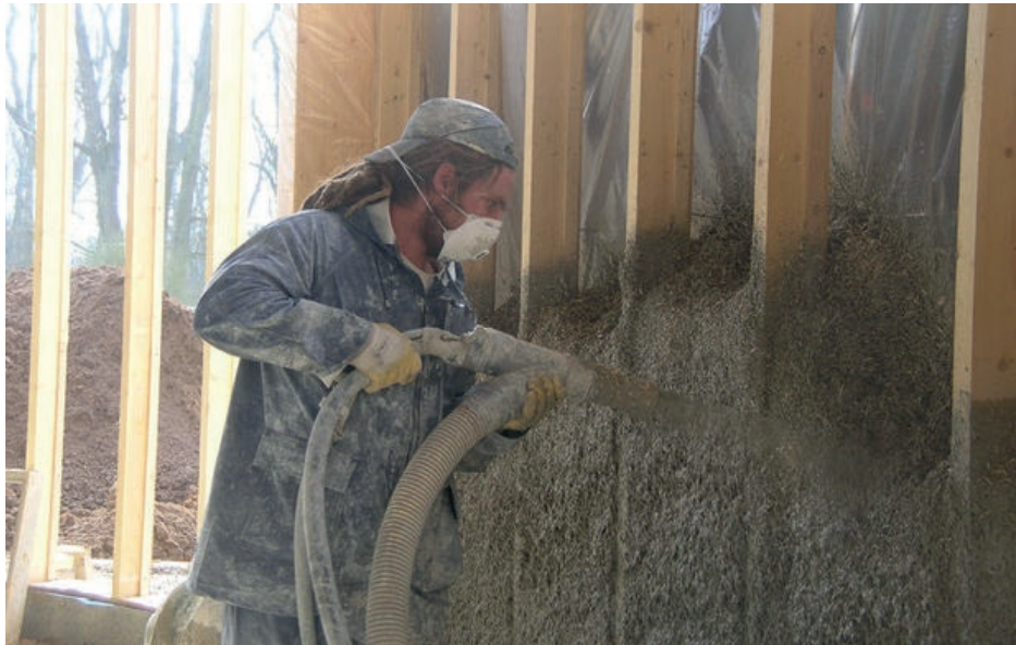
Mise en oeuvre
