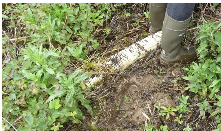
Illustration 24 : Drain agricole mis à jour au sud de l'ouvrage 62-1813. (Source : ©A-C De Rouck / Cerema HdF).
