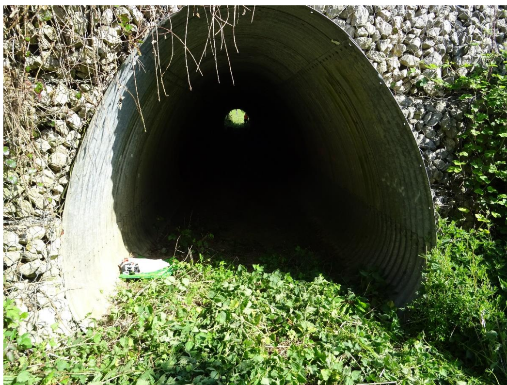
Illustration 6 : Ouvrage 62-1827, non destiné au passage de la faune sauvage, situé à 200m à l'ouest de l'ouvrage 62-1813. (Source : ©A-C De Rouck / Cerema HdF).
