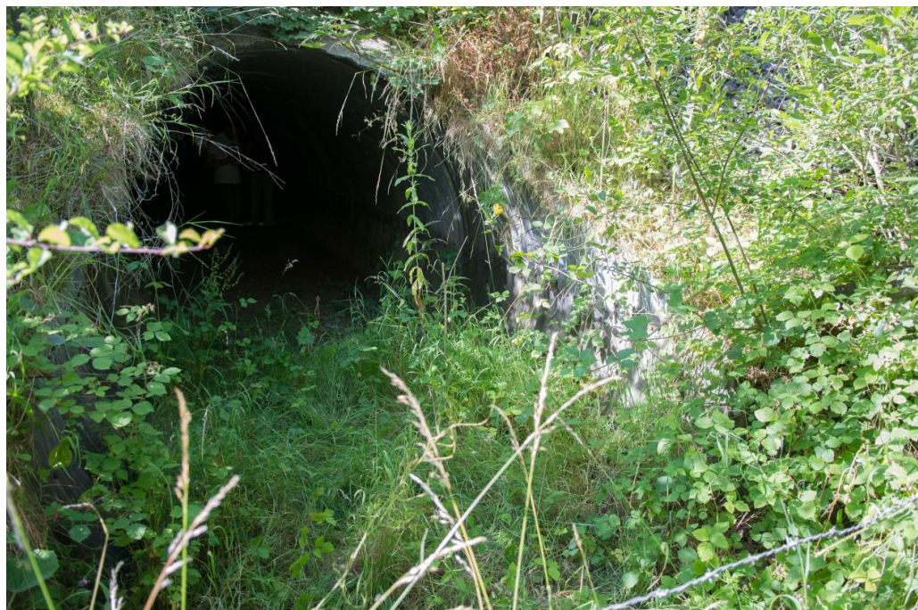
Illustration 7 : Entrée de l'ouvrage 62-1813 côté nord de la RN42. (Source : cc-by-sa-3 O. Pichard).
