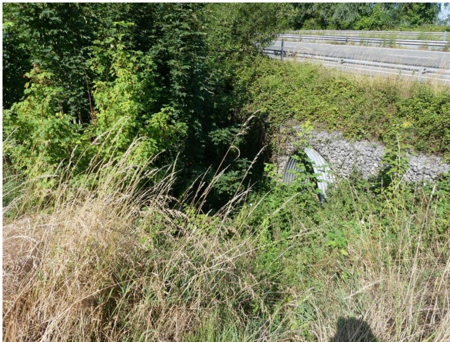
Illustration 13 : Entrée de l'ouvrage 62-1827 côté sud de la RN42. (Source : ©A-C De Rouck / Cerema HdF).
