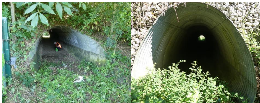
Illustration 15: Co-visibilité de part et d'autre de l'ouvrage 62-1827 (nord et sud. (Source : ©A-C De Rouck / Cerema HdF).
