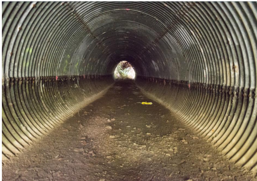
Illustration 9 : Intérieur de la buse métallique 62-1813 avec un sol en terre végétale. (Source : cc-by-sa-3 O. Pichard).
