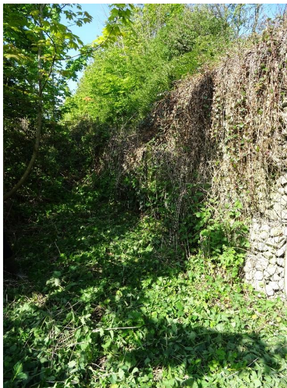
Illustration 18 : Linéaire arbustif et gabion servant de structure de guidage vers l'ouvrage 62-1827. (Source :).
