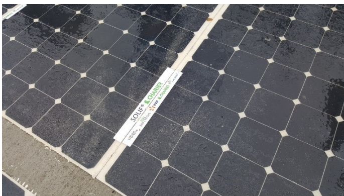
Figure 20: Photos de la route photovoltaïque SOLIF® déployée à Bouguenais (Source : Cerema)
