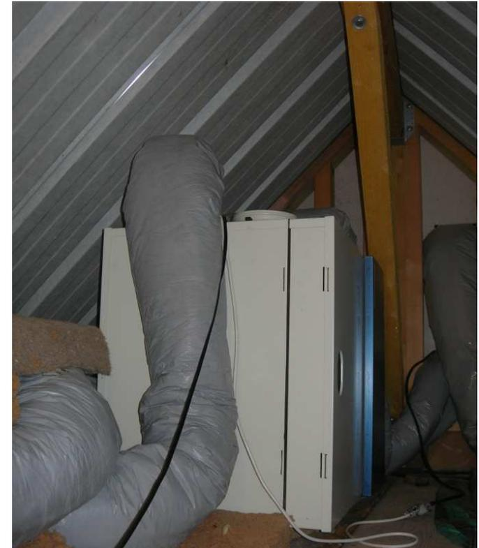
*Le positionnement de la centrale VMC DF dans les combles perdus peut-être à l'origine d'inconfort d'été*
