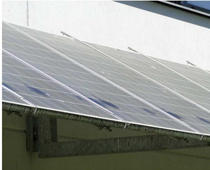
*Saleté accumulées sur des modules avec une faible inclinaison*
