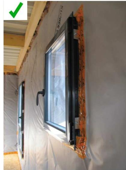
*Traitement des retours de pare-vapeur avec le plafond et traitement des percements*
