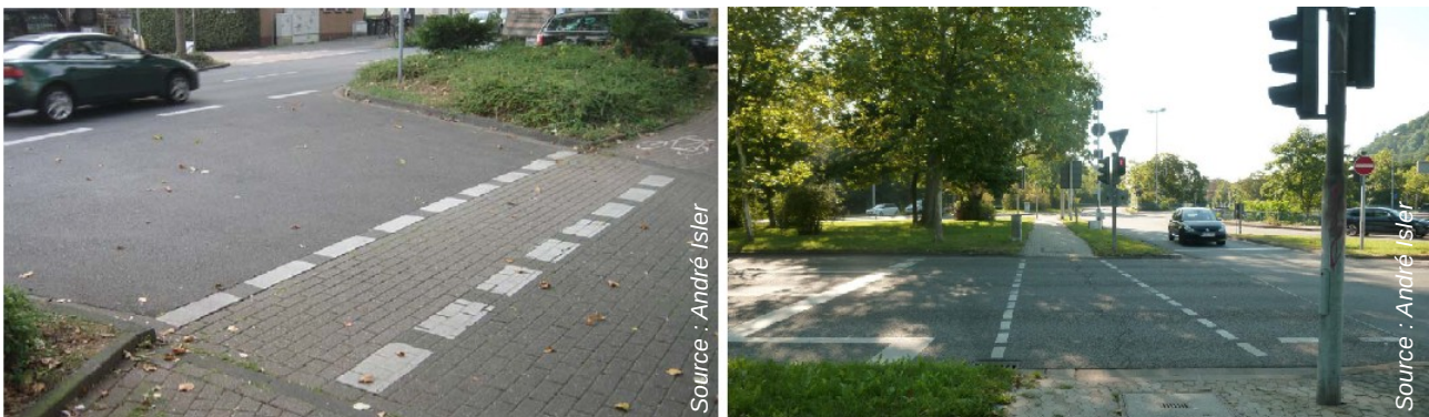
Traversée piétonne et cycliste, en continuité de trottoir partagé piétons - cyclistes
