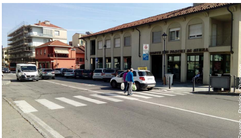
Passage pour piétons avec abaissé de trottoir, mais sans bandes podotactiles. Turin (Piémont).
