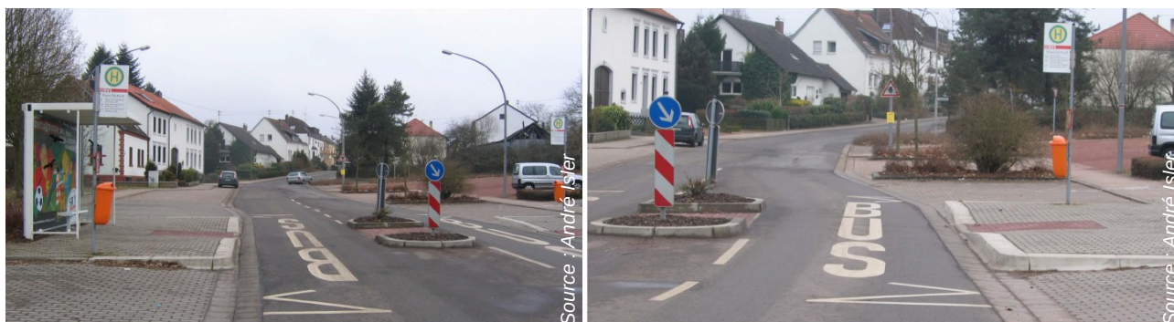
Traversée piétonne suggérée à proximité d'arrêts de bus (abaissés de trottoir et îlot central)
