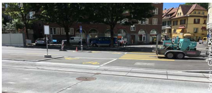
Passage pour piétons contiguë à une traversée cycliste
