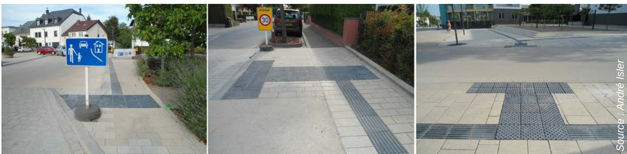
Bandes podotactiles en zone résidentielle et en zone 30. Luxembourg.
