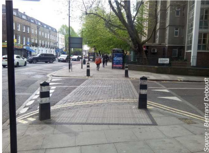
Uncontrolled crossing avec surélévation ; un aménagement assimilable aux traversées piétonnes suggérées en France
