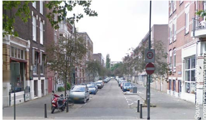
Un trottoir traversant en zone 30 à Rotterdam.
