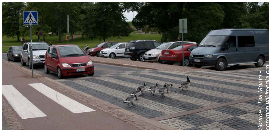
Une traversée piétonne matérialisée par un changement de revêtement au sol et une surélévation
