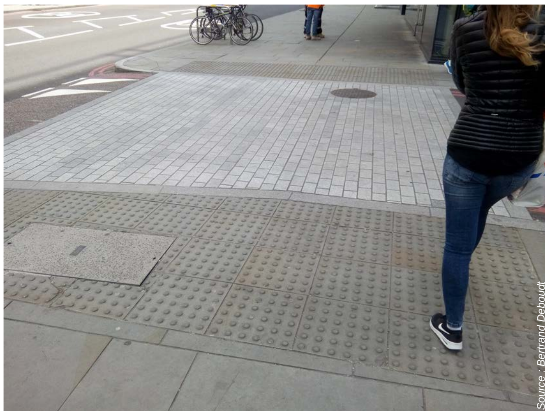
Pavage tactile en amont d'une traversée piétonne suggérée
