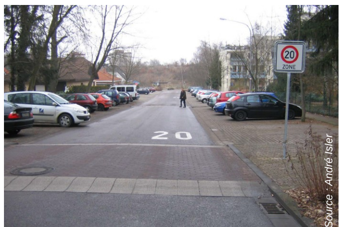
Trottoir traversant en entrée de zone de circulation apaisée
