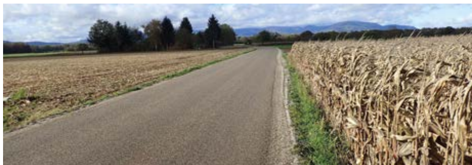
Figure 8 / ORRAP France - Enduit superficiel d'usure en finition. Source Cerema
