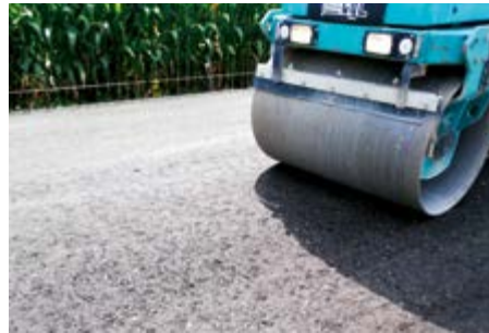
Abbildung 7 / ORRAP Schweiz & Frankreich - Verdichtung. Quelle: Cerema
