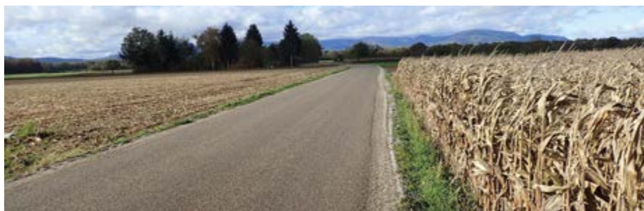
Abbildung 8 / ORRAP Frankreich - Oberflächenversiegelung als Endbehandlung. Quelle: Cerema
