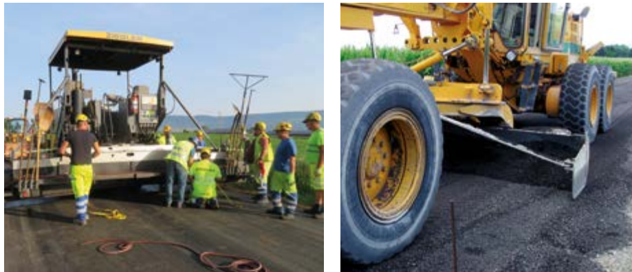
Abbildung 3/ ORRAP Schweiz & Frankreich - Einbau mit Straßenfertiger/Grader Quellen: Empa & Cerema
