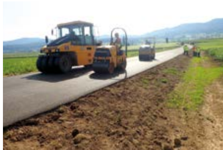
Abbildung 7 / ORRAP Schweiz & Frankreich - Verdichtung. Quelle: Cerema
