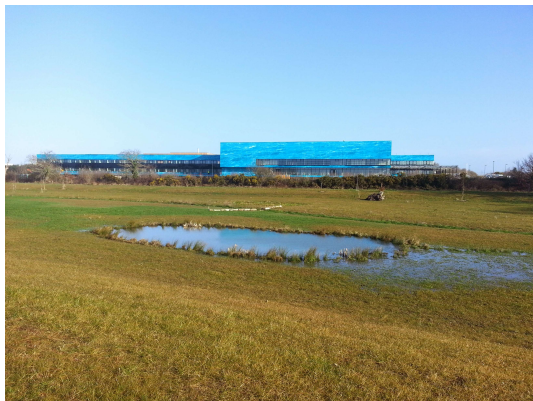
Exemple : prise en compte de zones humides dans la ZAC Moulin Cassé Croix Rouge Commune de Bouguenais
