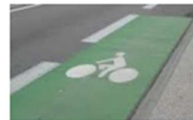
Aménagements cyclables et cheminements piétons
