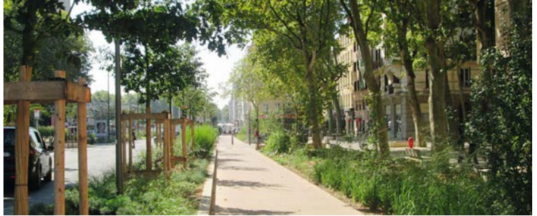
La rue Garibaldi après travaux Photo issue de l'article les dossiers de l'ingénierie territoriale « L'arbre un climatiseur naturel » Témoignage de Frédéric Ségur – Grand Lyon
