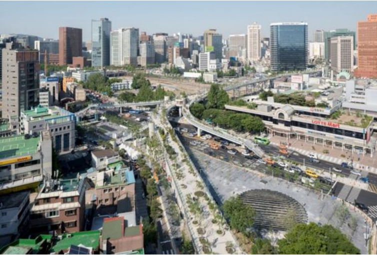
Requalification de l'ouvrage en jardin suspendu
