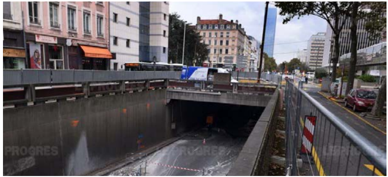
Article du journal Le Progrès – Photo de Philippe Juste Le rue Garibaldi – Lyon – Avant travaux
