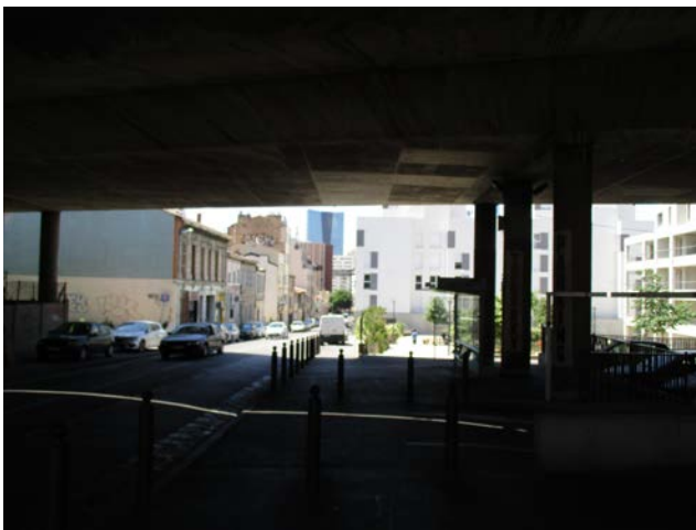
Traverser l'autoroute – Rue Auphan
