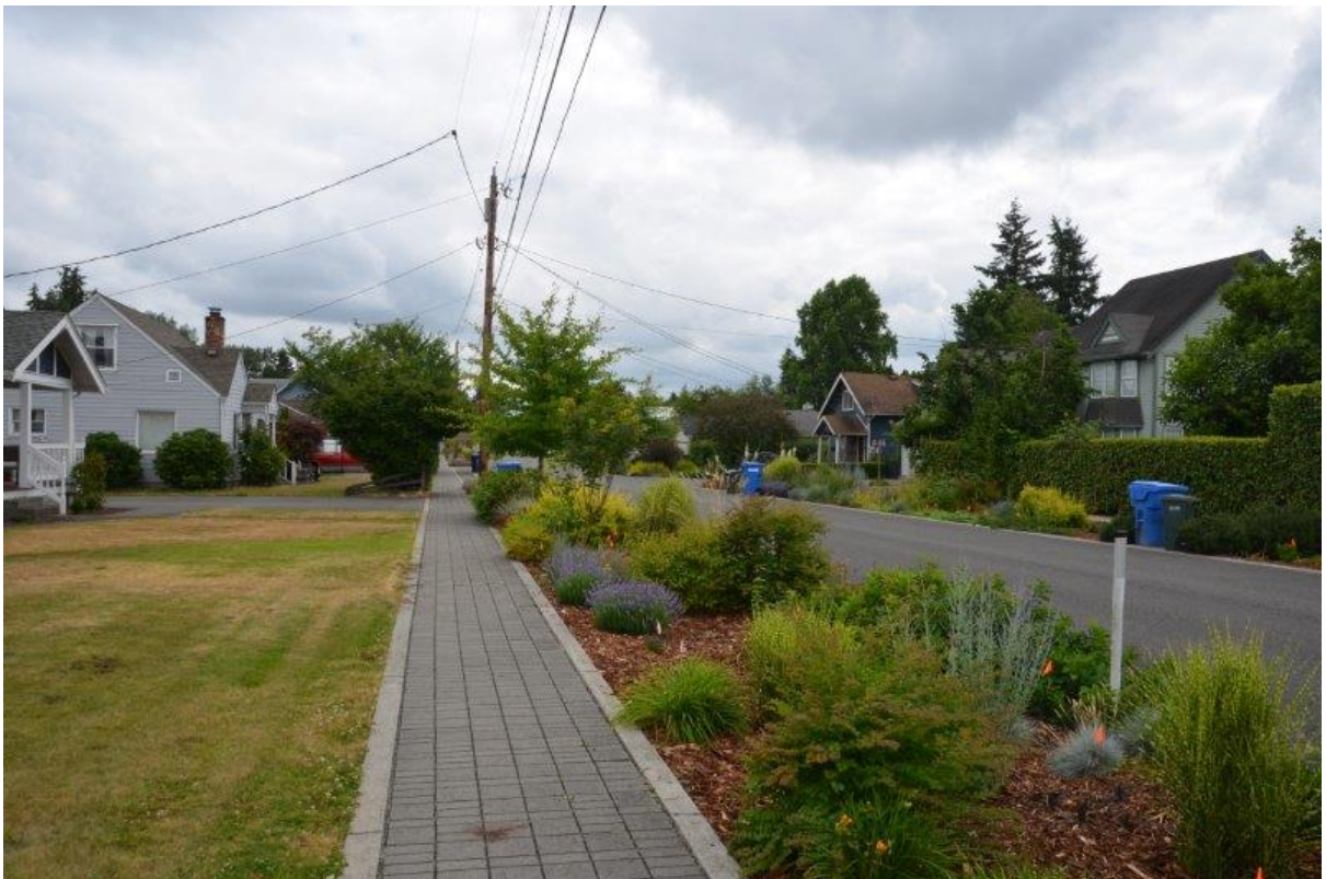
Illustration 24 : Une bande linéaire de plantations en creux longe la route du quartier. L'eau de ruissellement est gérée et infiltrée dans cette noue plantée. Crédit : Cerema.
