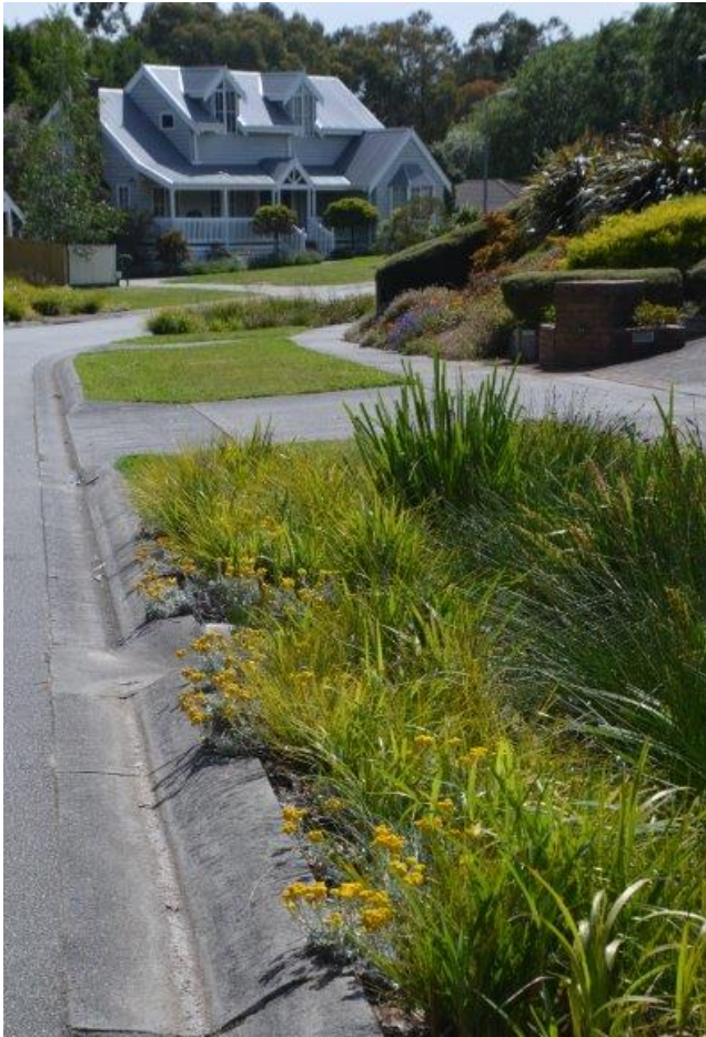
Illustration 50 : Détails des aménagements, l'eau de ruissellement de la voirie est envoyée vers un espace filtrant planté. Crédit : Cerema.
