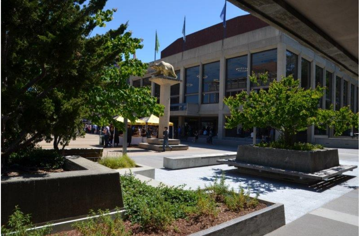
Illustration 42 : Vue des aménagements de la Lower Spoul Plaza de l'Université de Berkeley. L'eau de ruissellement de cette place est captée et renvoyée vers des jardins de pluie connectés à un ruisseau en contre-bas. Crédit : Cerema.
