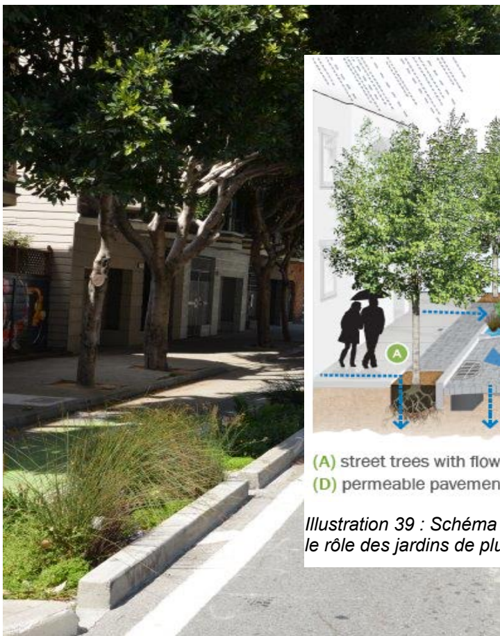
Illustration 38 : Ci-dessus, deux vues d'un aménagement de jardins de pluie qui a également une fonction de signallement de la piste cyclable à l'entrée d'un croisement. Crédit : Cerema.
