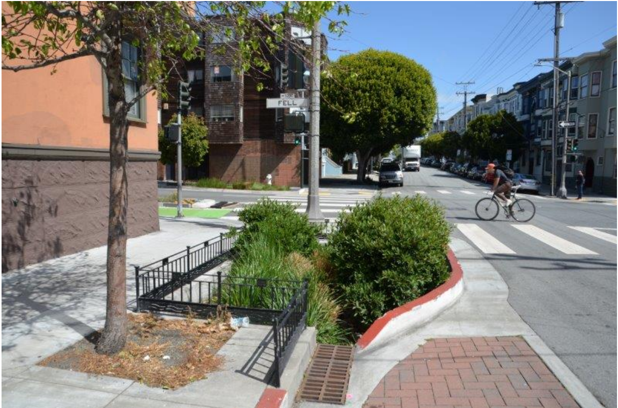
Illustration 36 : Un exemple de jardin de pluie intégré dans l'aménagement public dans l'hyper-centre de San Francisco. Crédit : Cerema.
