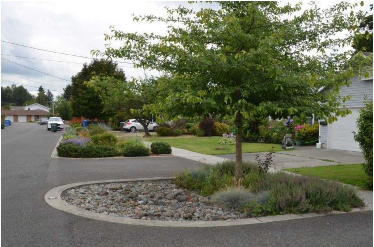
Illustration 25 : De nombreux aménagements participent à l'amélioration du cadre de vie et à la gestion du ruissellement. La photo ci-dessus présente un aménagement intégrant du minéral sous la forme de galets, accompagné de graminées et de bruyères. Ci-dessous, à proximité, les jardins de pluie sont essentiellement plantés d'arbustes bas. Crédits : Cerema.
