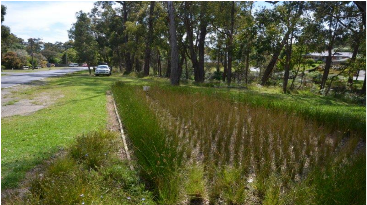
Illustration 49 : Un bassin tampon planté permet de filtrer et de réguler les eaux de ruissellement en amont, avant son passage vers le ruisseau. Crédit : Cerema.
