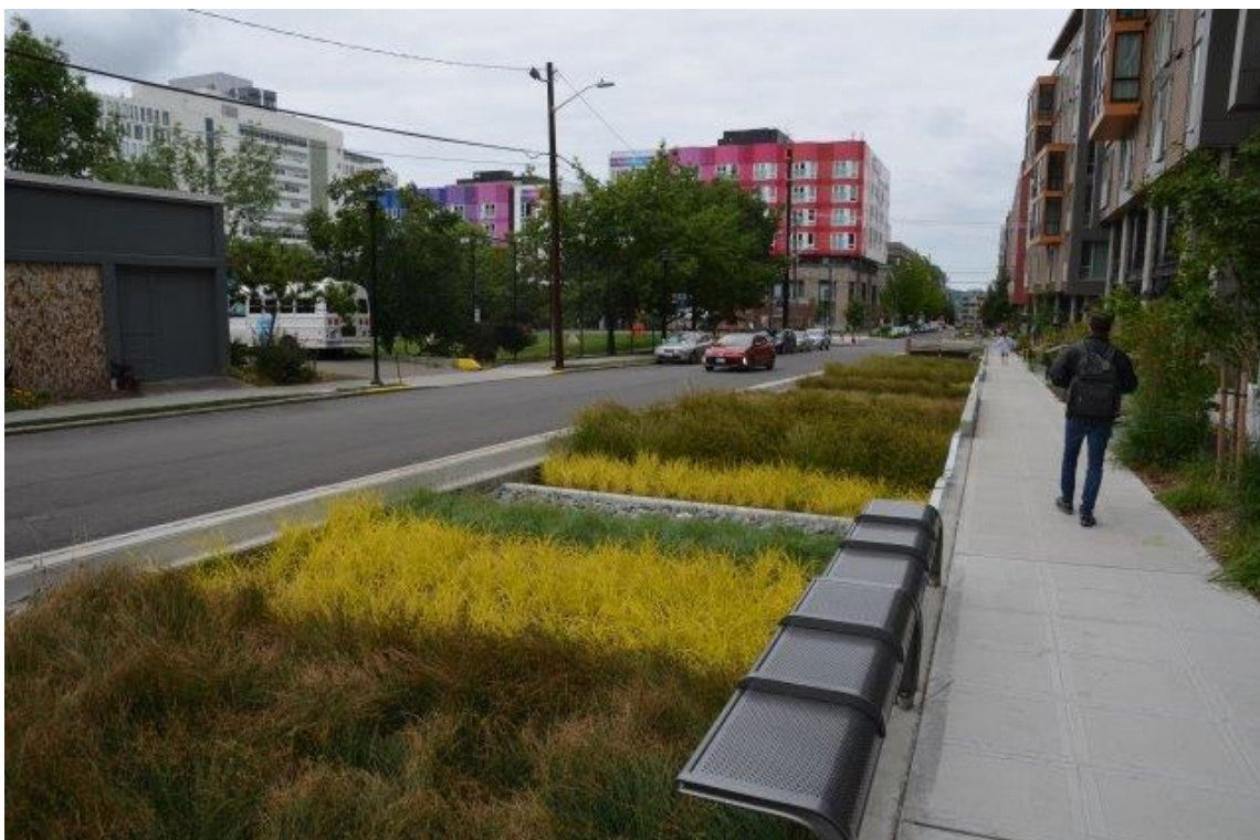
Illustration 44 : Aménagement d'une rue avec des jardins de pluie en série dans un quartier récent de Seattle. Crédit : Cerema.
