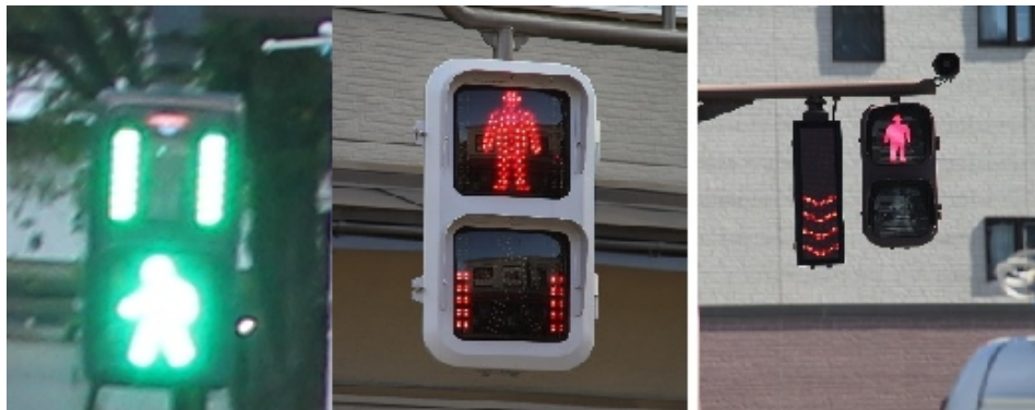
Illustration 35: Différents feux piétons observés au Japon. (source : Cerema)
