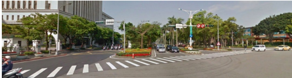
Illustration 38 : Passage piéton très long sans refuge à Taïwan.
