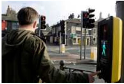
Photo 2.3 Exemple de signal sur le trottoir de départ, en Angleterre
