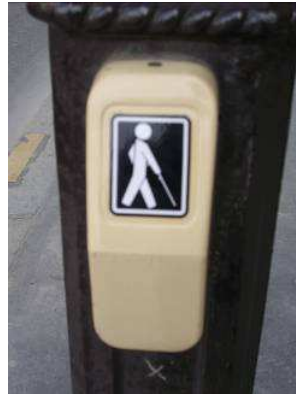
Photo 2.7 Exemple de répéteur sonore à télécommande et bouton-poussoir, à Paris
