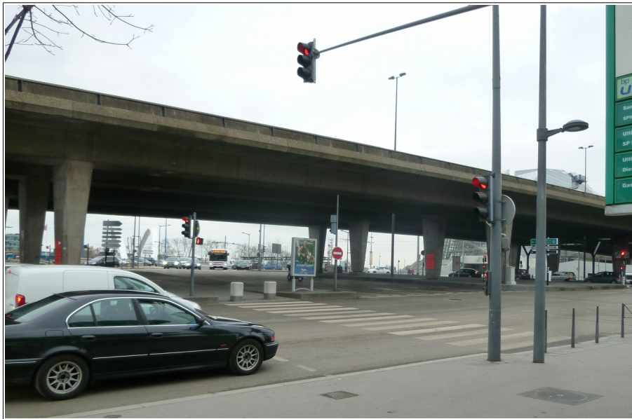
Illustration 24: Photo du carrefour Pasteur (source : Cerema)
