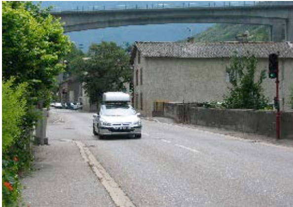
Premier carrefour ( Truchet /Merlatière/Gare) sens entrée d'agglomération
