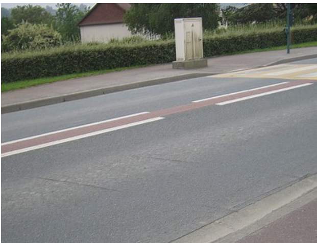
La boucle courte distance, à 3m du feu
