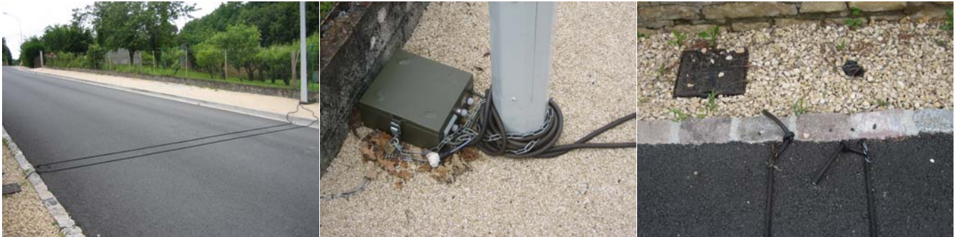
Figure 5 : Mise en place du compteur MIXTRA
