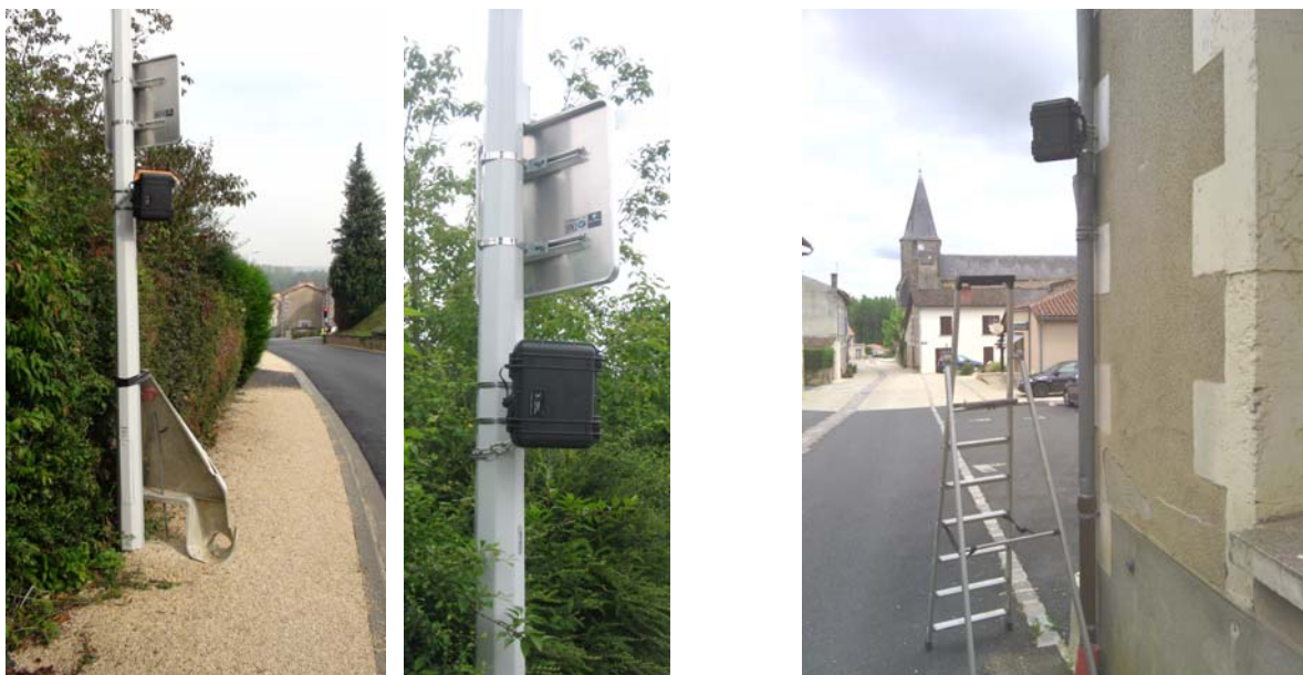
Figure 9 : Radars TMSSA amont (à gauche et au milieu) et aval (à droite)
