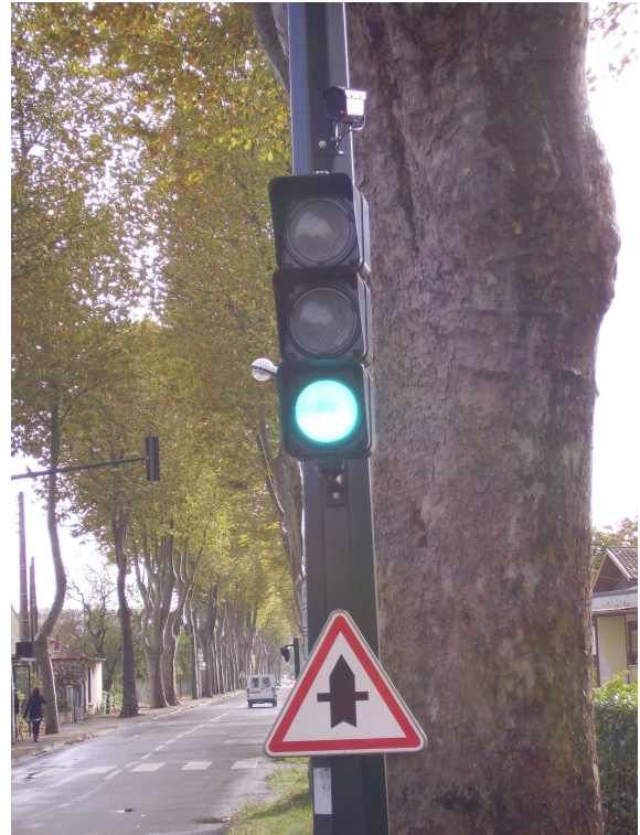
Feu et détecteur asservi à la vitesse RD62 vers centre ville
