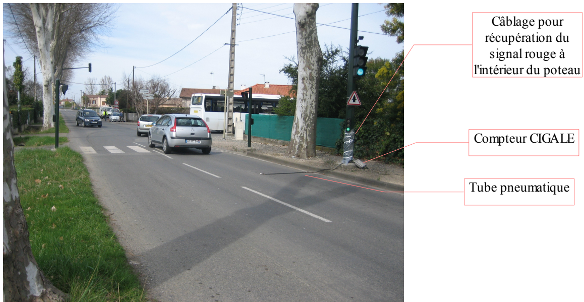
Compteur Cigale implanté au droit du feu asservi à la vitesse – RD62 en direction d'A64
