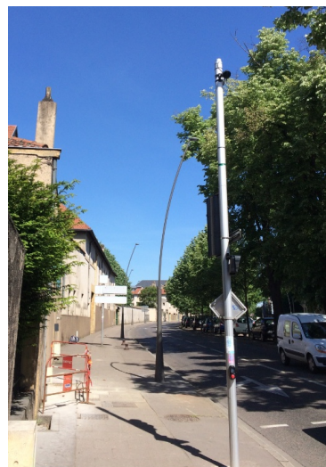
Illustration 8: Capteur installé sur le support de feu du boulevard Paixhans
