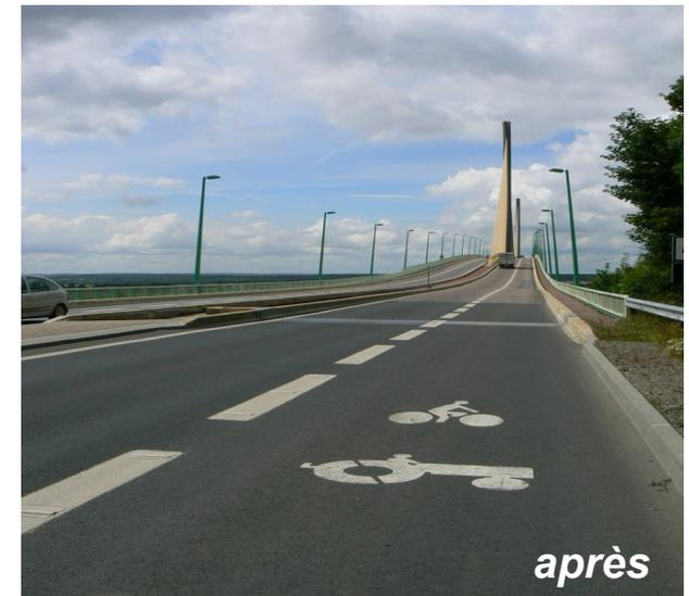
**Pont de Brotonne** : passage de 2x2 voies à 1x1 voie avec réalisation d'une voie mixte engins agricoles et vélos
