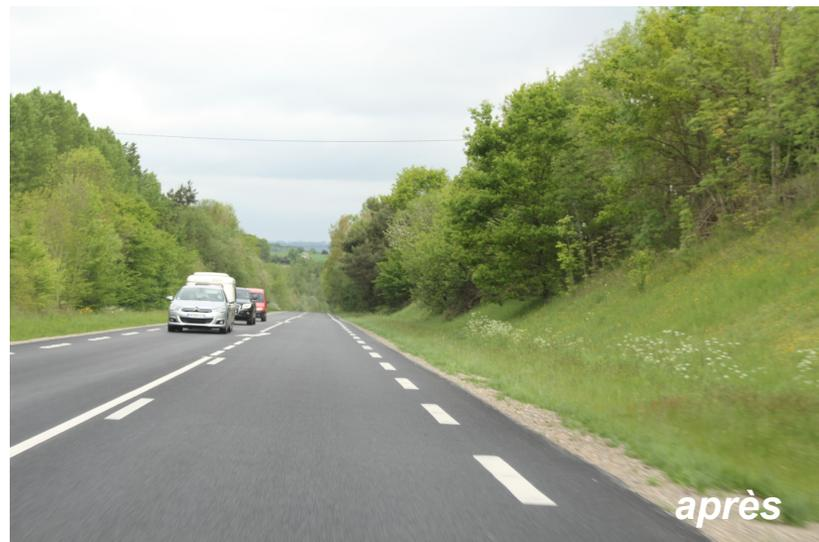
***Section bidirectionnelle : réduction des largeurs de voie au profit d'une bande dérasée de droite et mise en œuvre de dispositifs d'alertes sonores***
