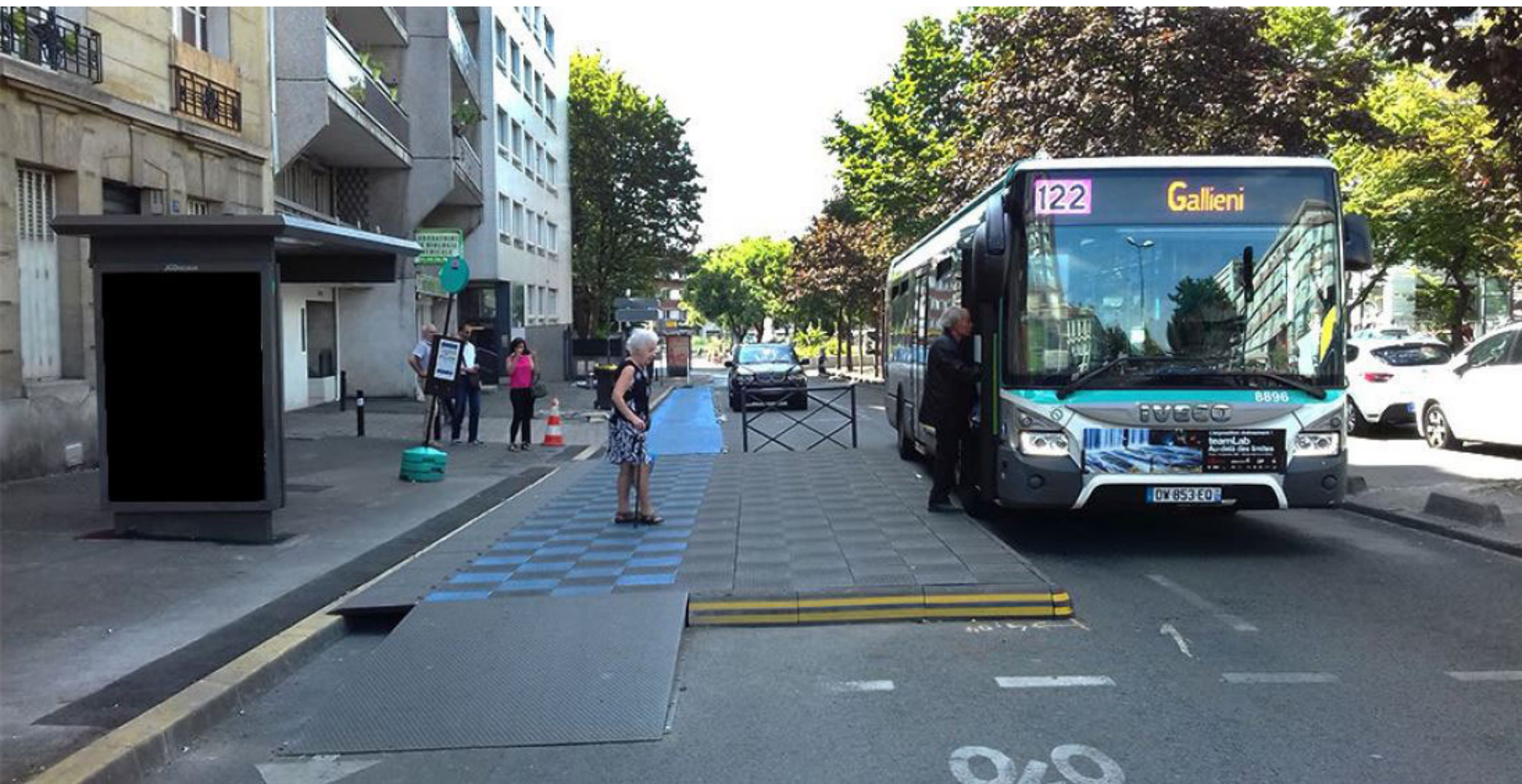
Quai bus « Vectoriel » de Zicla – arrêt Croix de Chavaux à Montreuil
