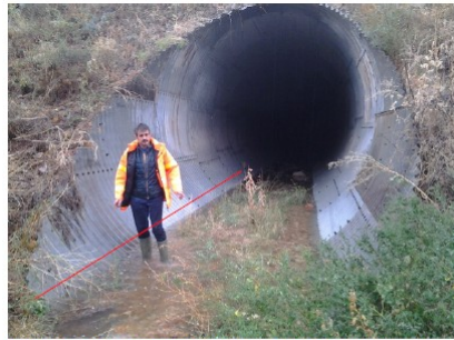
Buse PR289+200 13/10/2016 14h10 (aval; hauteur d'eau de 25 cm environ sur 20 cm d'atterrissements).
