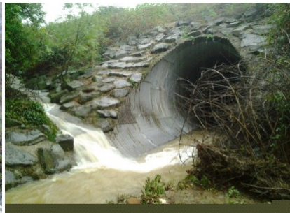
Buse PR289+200 14/10/2016 8h30 (amont: écoulement d'eau en provenance de l'A75).
