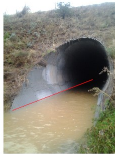
Buse PR289+200 14/10/2016 8h45 (aval; hauteur d'eau de 30 à 40 cm environ sur 20 cm d'atterrissements).
