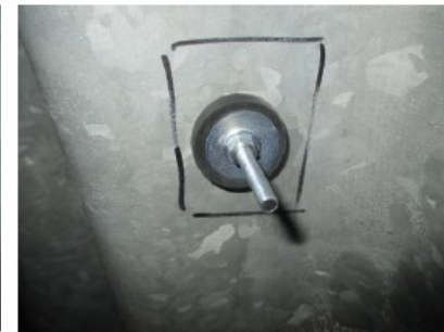
Zone après rebouchage.
