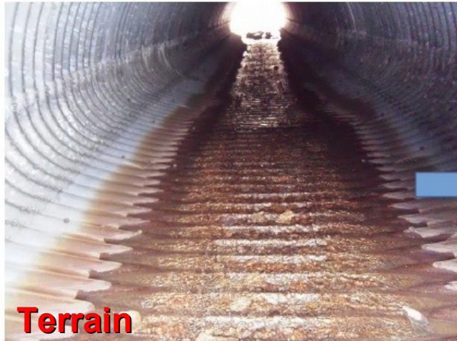
Déformation locale en plan (jonction BM1 et BM2).
