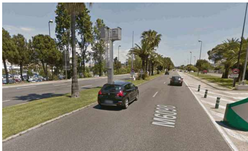
ETF sur un mât avant la mise en place de l'ET2F
